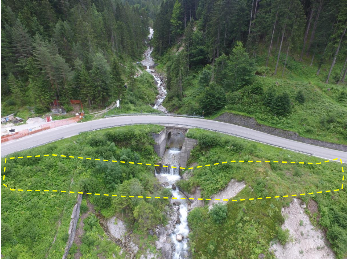
Figura A.4.1: Foto di dettaglio dell'ambito di inserimento del ponte (vista NO-SE).
