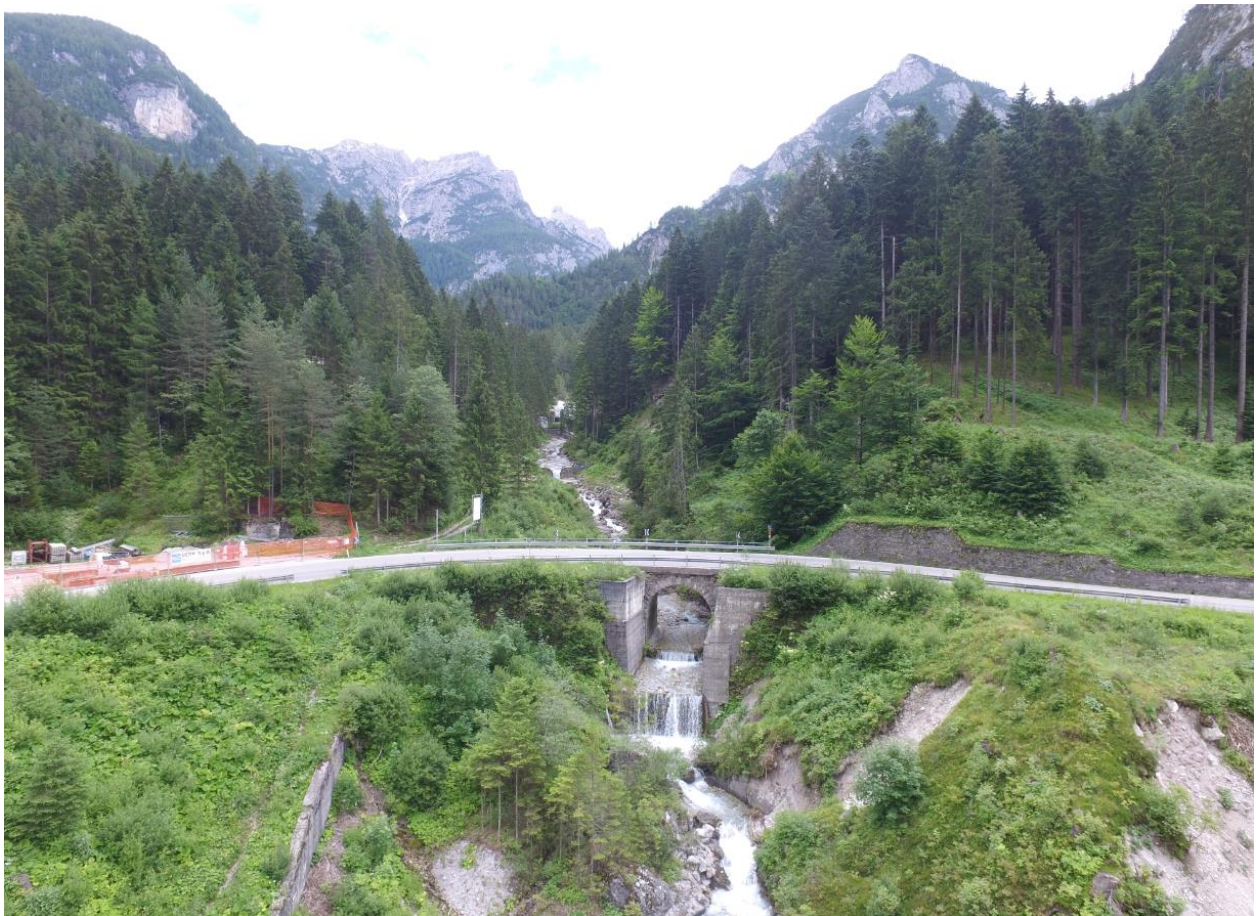
Figura A.3.3: Fotografia ambito di inserimento del ponte di progetto.
