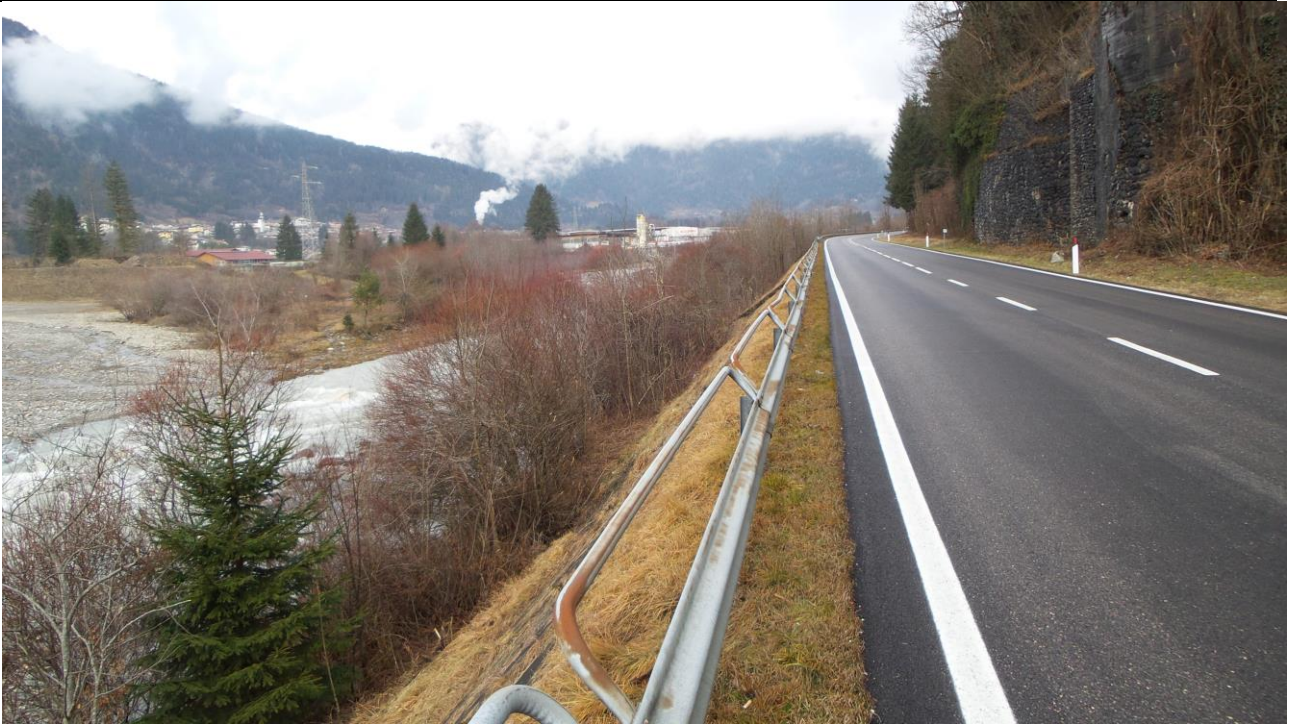
Foto 3: Stato attuale della Km 12+740
