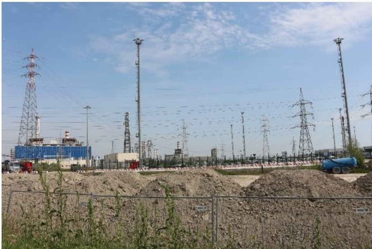
Figura 4.7.18 – Punto di vista 5 – Stato di fatto
