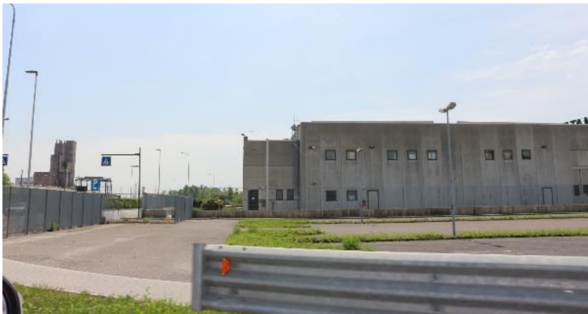
Figura 4.7.5 - Impianti industriali a Fusina
