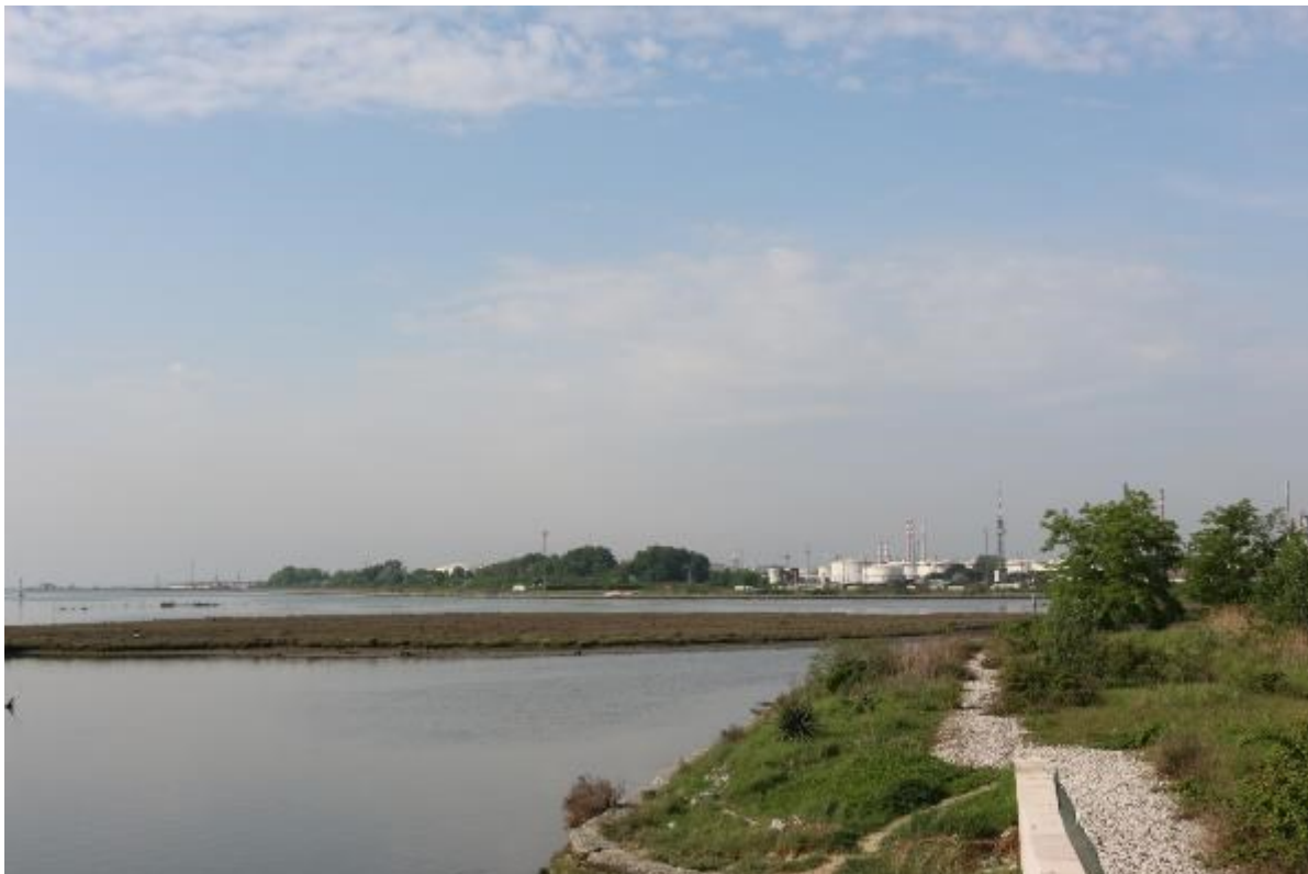
Figura 4.7.22 – Punto di vista 7 – Stato di fatto
