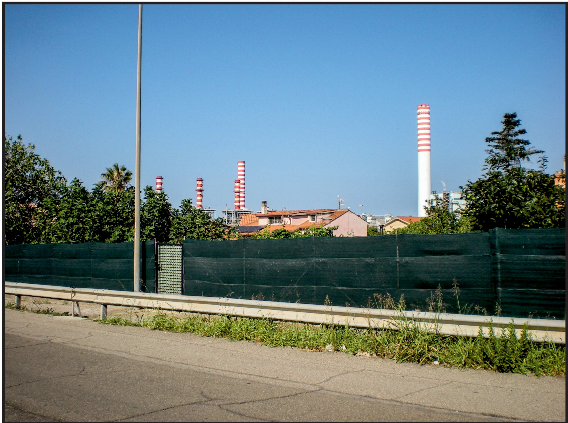
TORREVALDALIGA (RM) - CENTRALE ENEL - - VISTA 2 - STATO ATTUALE
