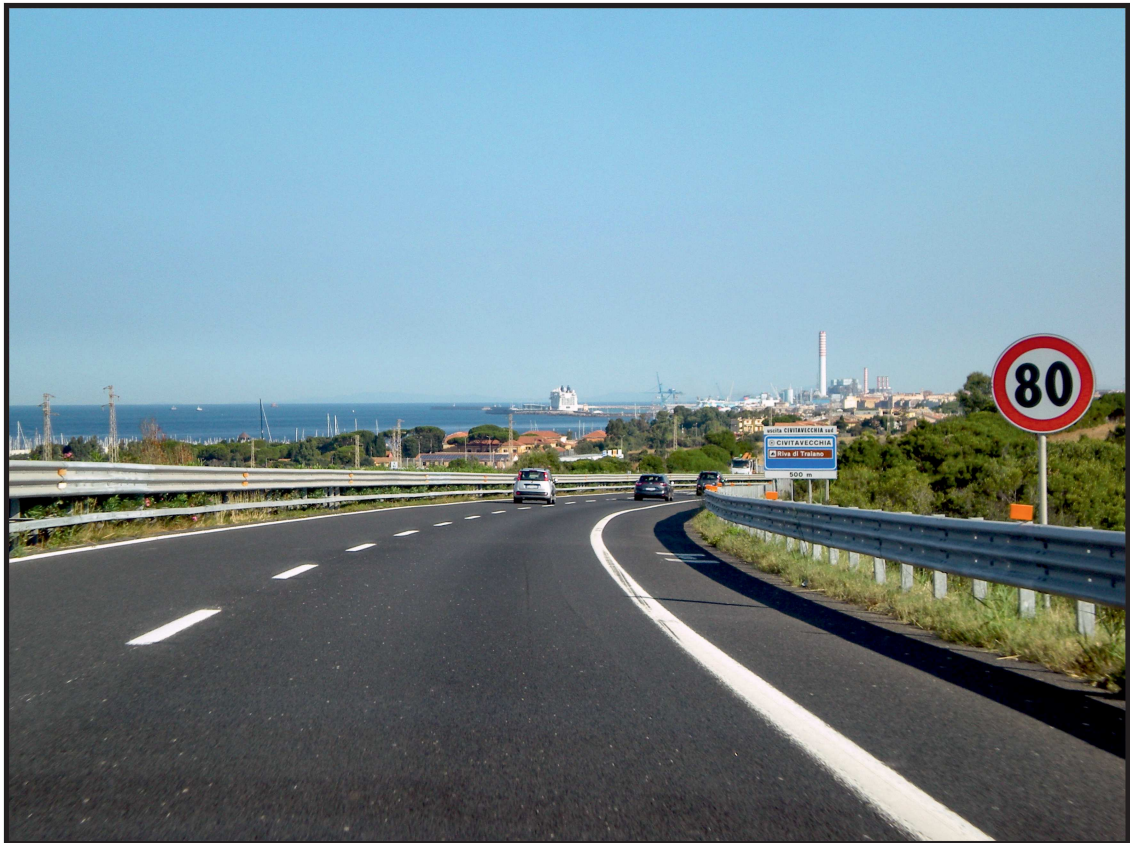
TORREVALDALIGA (RM) - CENTRALE ENEL - - VISTA I - STATO FUTURO - DUE CICLI APERTI I I 20 MW
