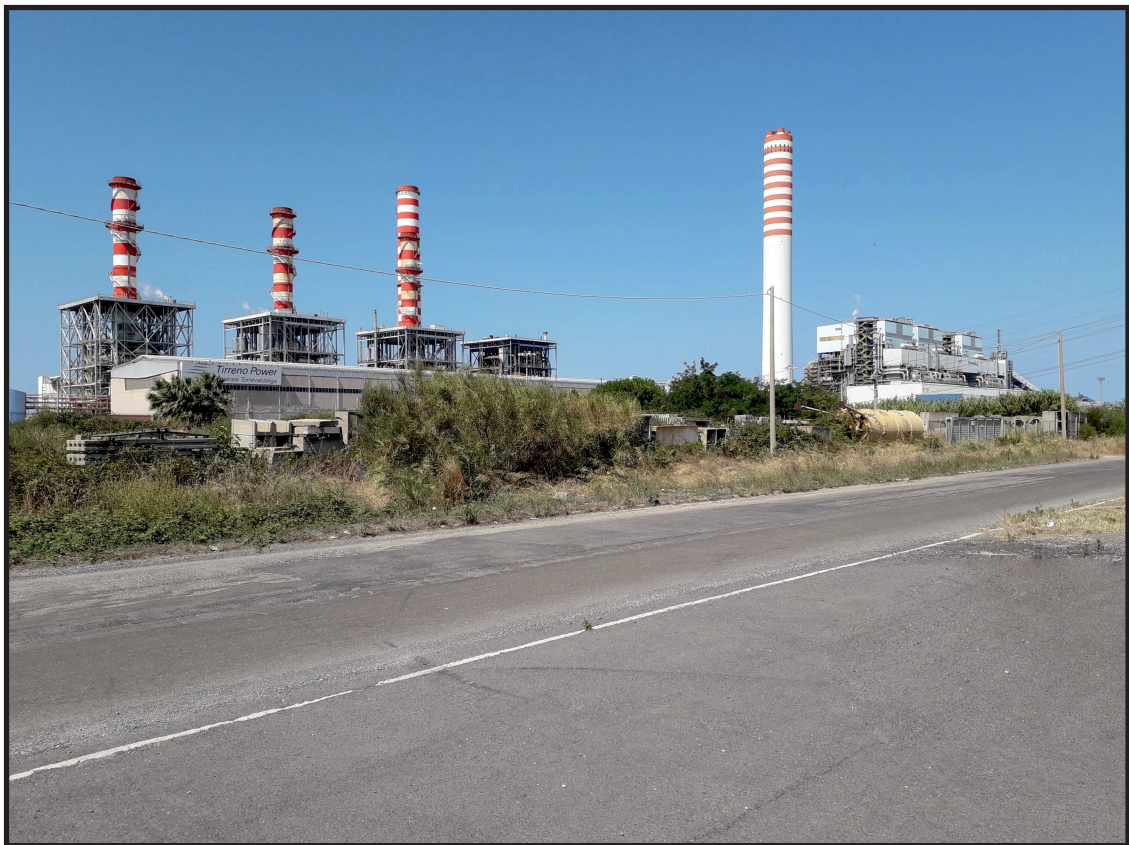
TORREVALDALIGA (RM) - CENTRALE ENEL - - VISTA 3 - STATO ATTUALE -
