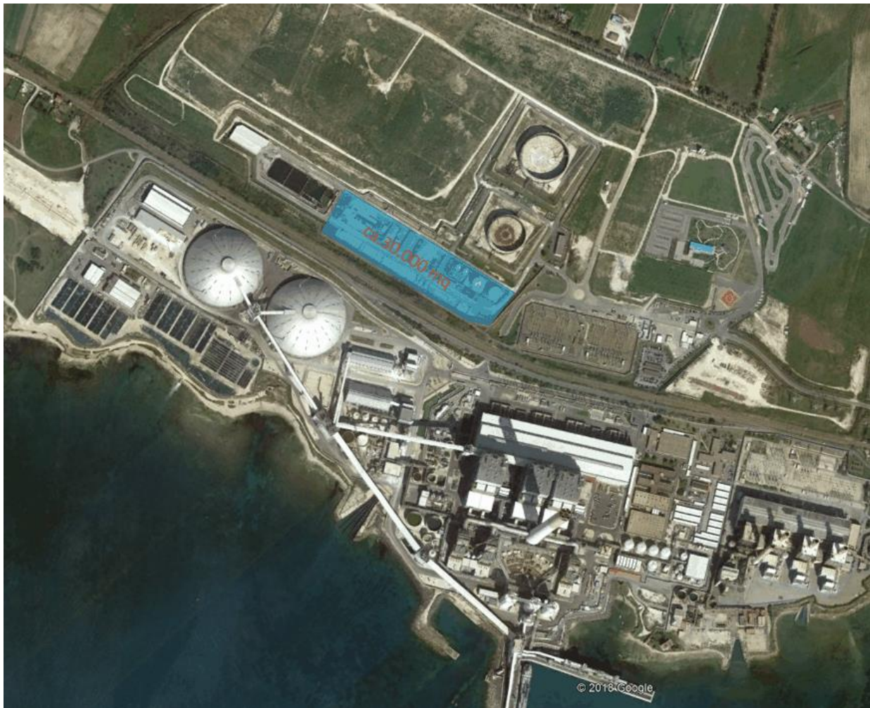
Figura 3.4.2 – Fase-1 e 2: area di cantiere all'interno del sedime dell'attuale centrale
