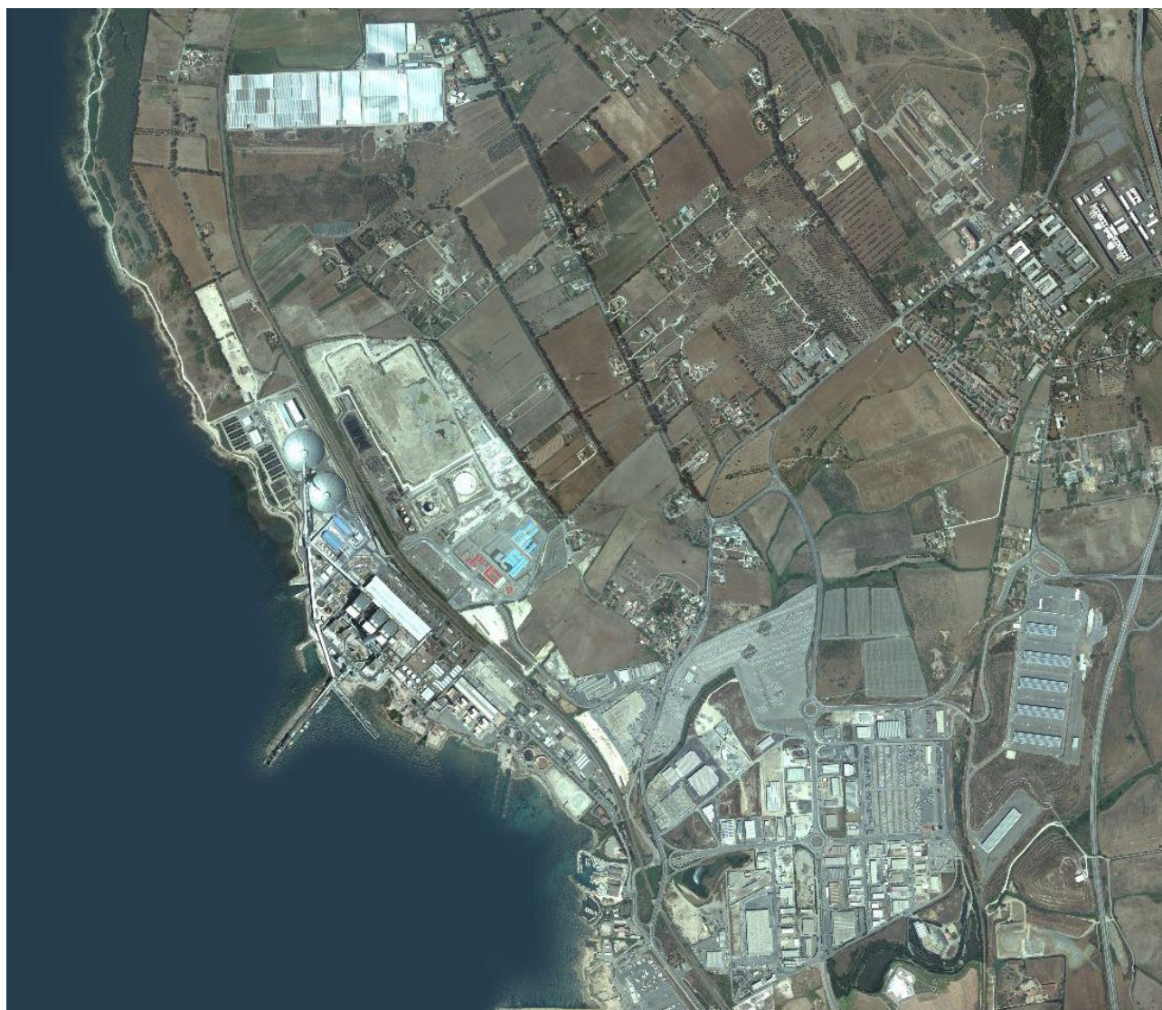
Figura 21 - L'area di Torrevaldaliga nel 2012
