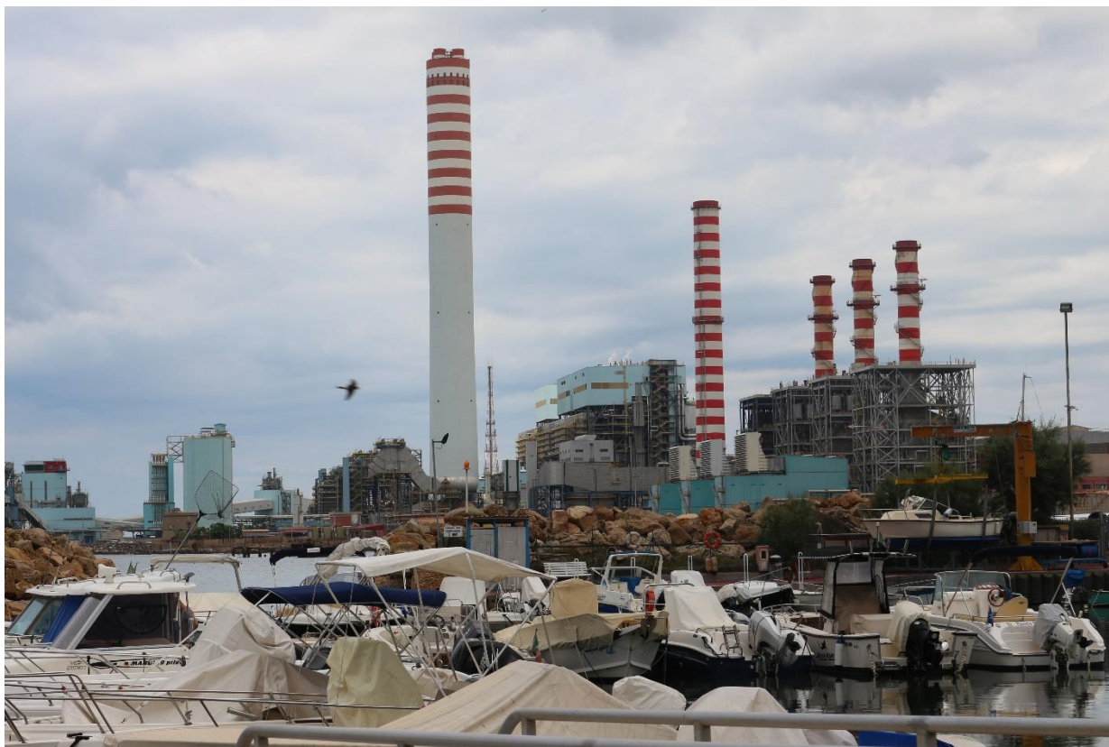
Figura 5.11 – Punto di vista 6 – Stato di fatto
