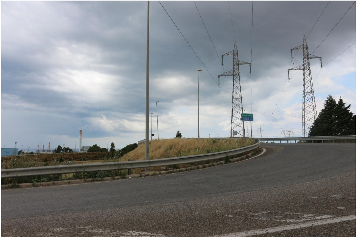
Figura 5.5 – Punto di vista 3 – Stato di fatto
