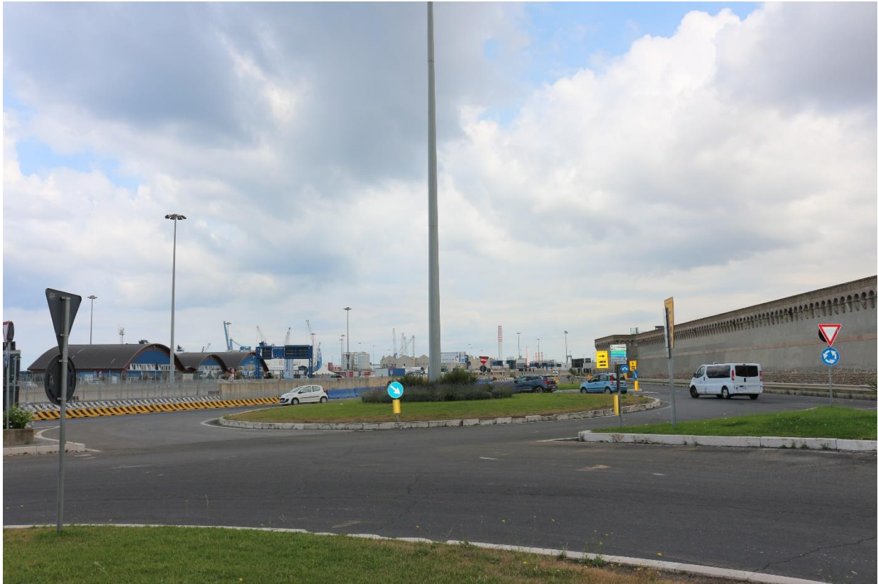
Figura 5.9 – Punto di vista 5 – Stato di fatto
