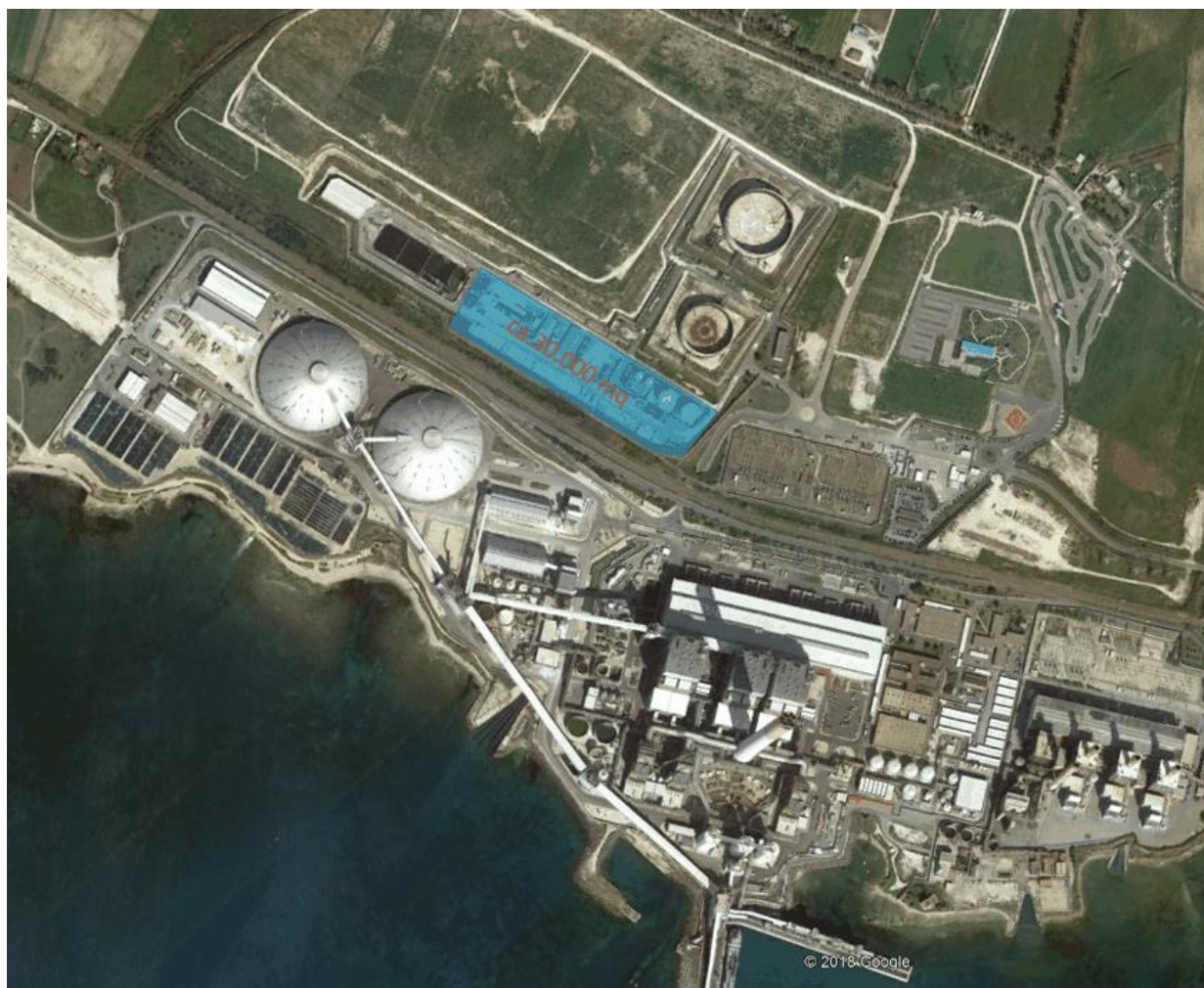
Figura 2.3 – Localizzazione dell'area di cantiere delle fasi 1 e 2
