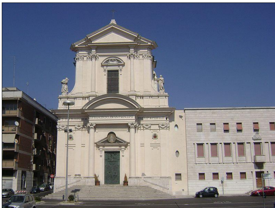
Figura 4.6 - Cattedrale dedicata a San Francesco d'Assisi - facciata
