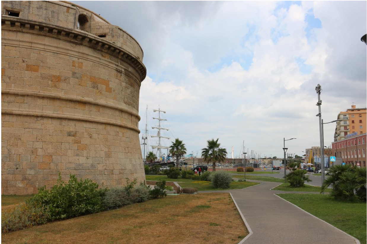
Figura 5.13 – Punto di vista 7 – Stato di fatto
