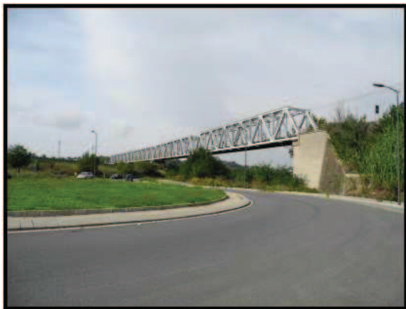
Figura 1: Rotonda nei pressi Ponte Ferrato della Ferrovia
