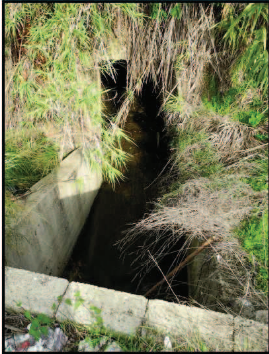
Figura 2: Fosso per far defluire le acque nei pressi del ponte ferrato
