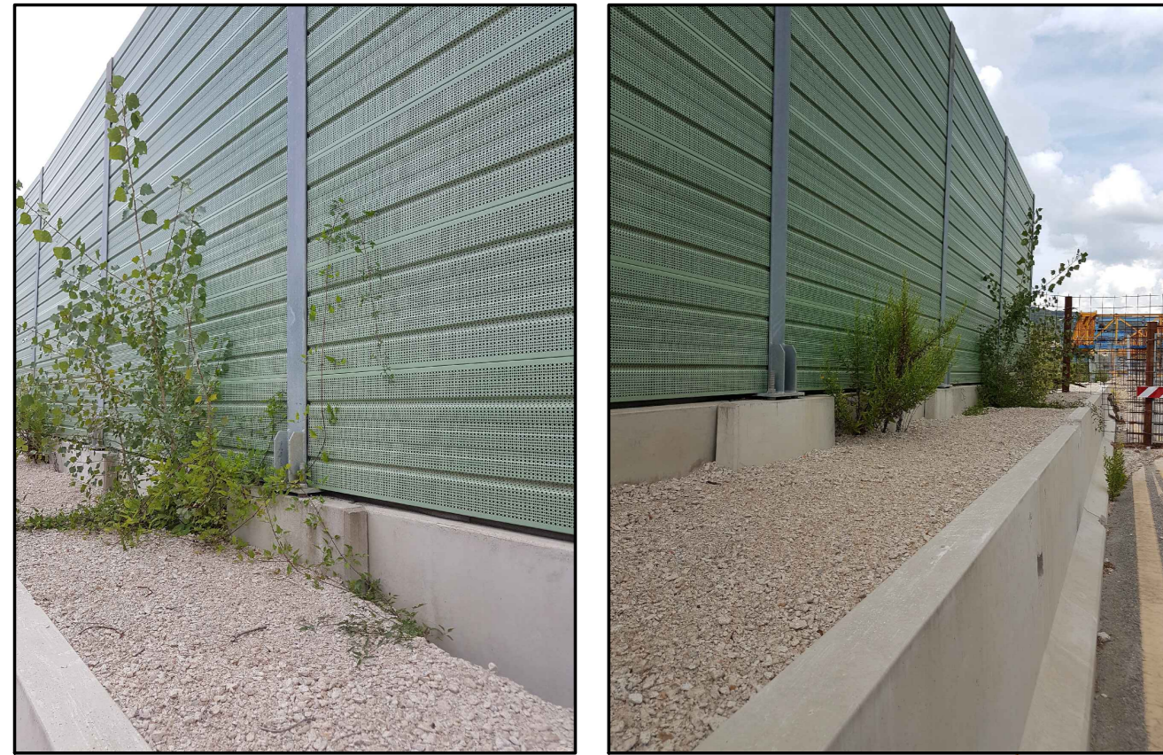
Barriera antirumore esistente
