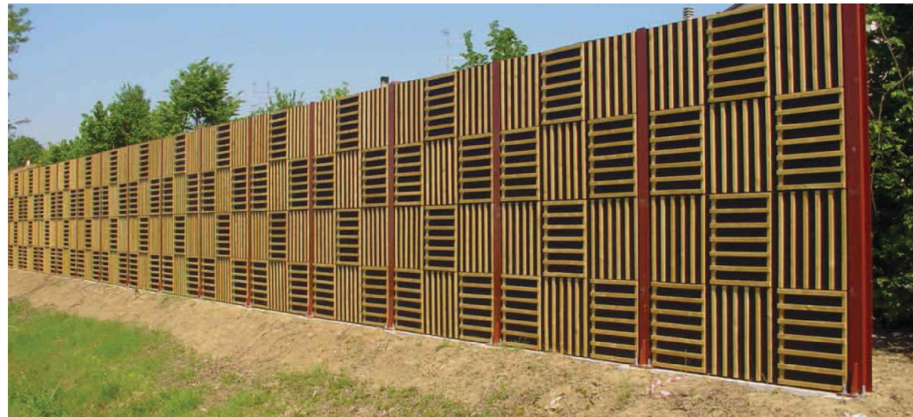
Particolari barriera antirumore in legno proposta
