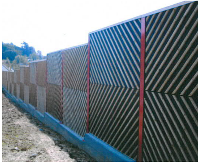
Figura 6 - Barriera acustica in legno – motivo con listelli disposti in diagonale
