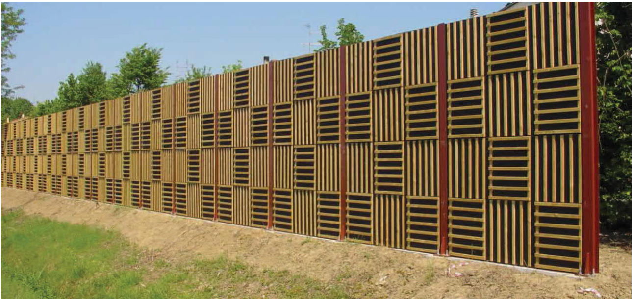
Figura 7 - Barriera acustica in legno – motivo con listelli disposti a scacchiera
