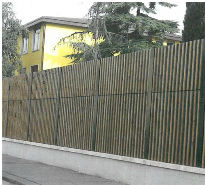
Figura 5 - Barriera acustica in legno – motivo con listelli disposti in verticale
