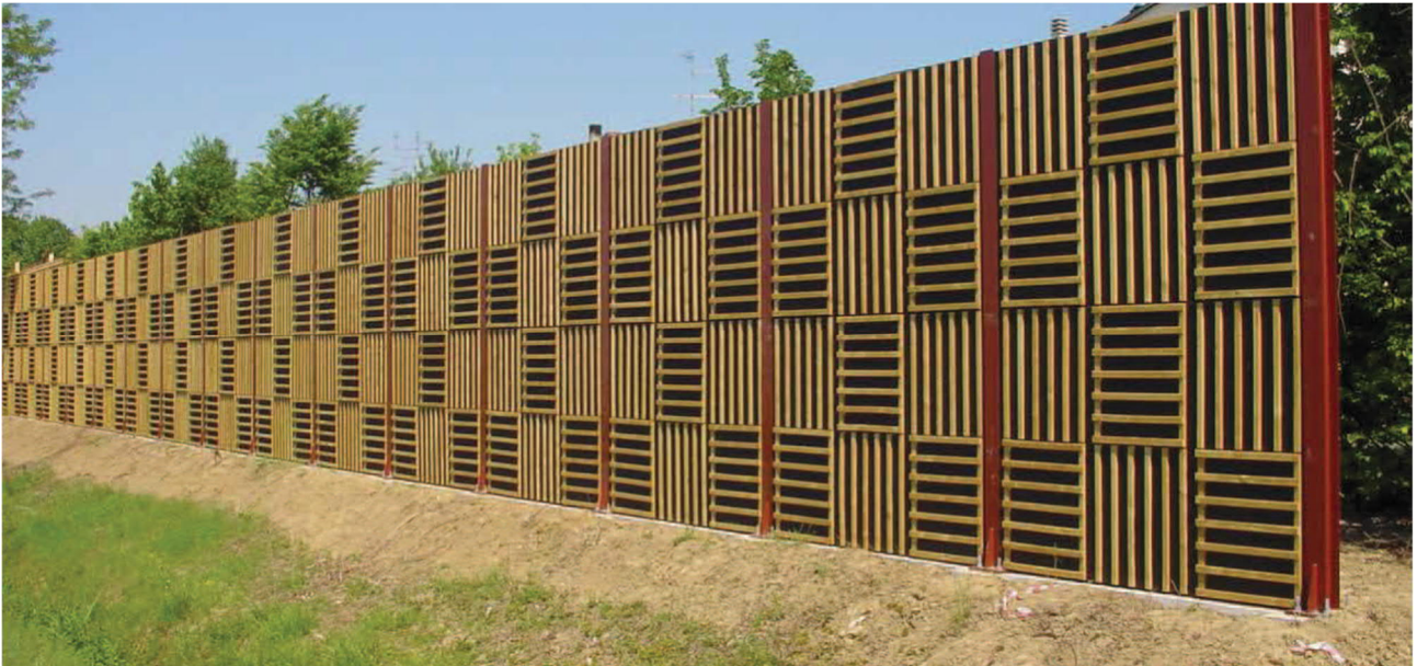
Figura 32 - Barriera acustica in legno – motivo con listelli disposti a scacchiera
