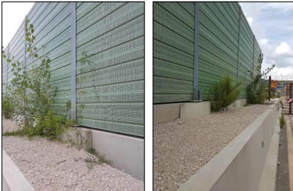
Figura 21 – Fotografie barriere esistenti
