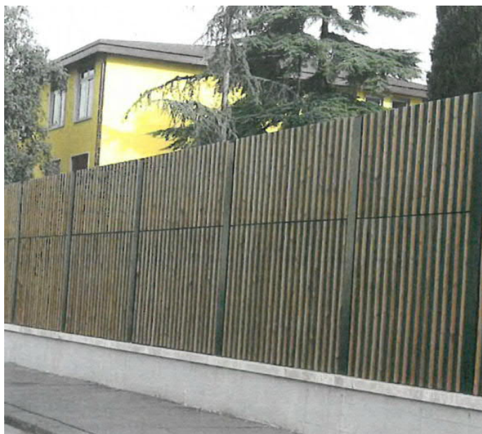
Figura 30 - Barriera acustica in legno – motivo con listelli disposti in verticale
