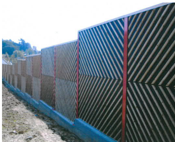
Figura 31 - Barriera acustica in legno – motivo con listelli disposti in diagonale
