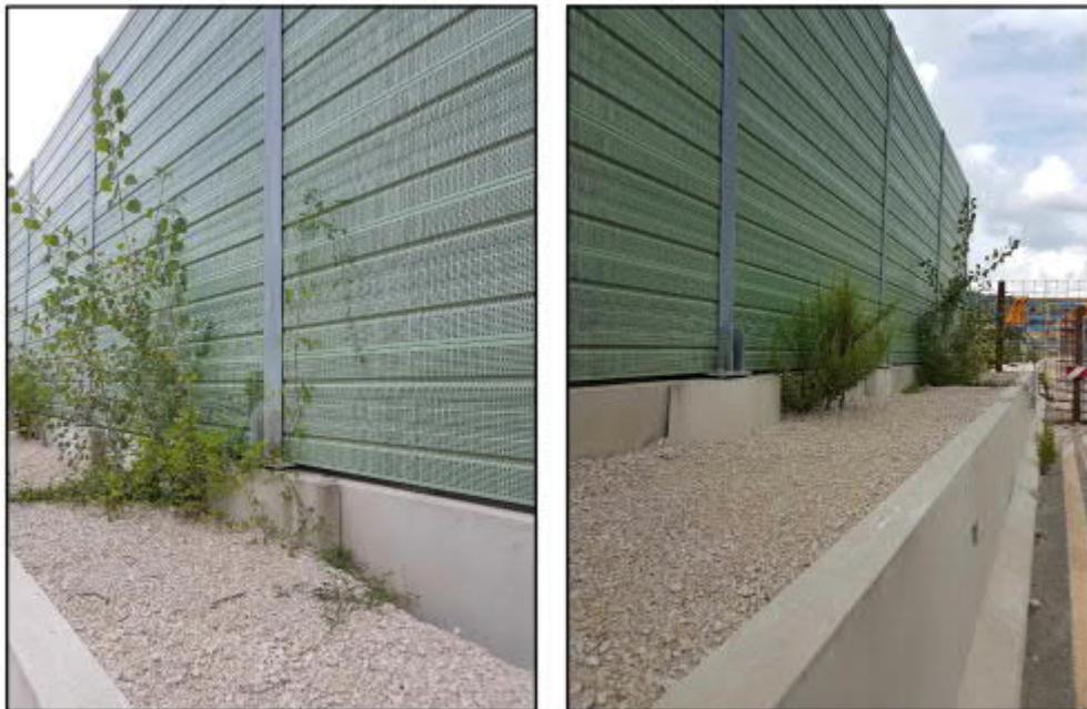
Figura 7 – Fotografie barriere esistenti
