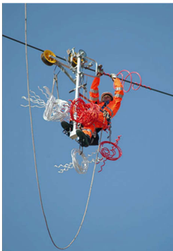
Figura 7-B - Montaggio di dissuasori visivi.
