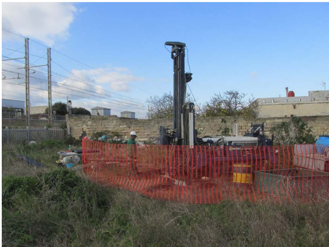
Sondaggio S1: Avanzamento sondaggio
