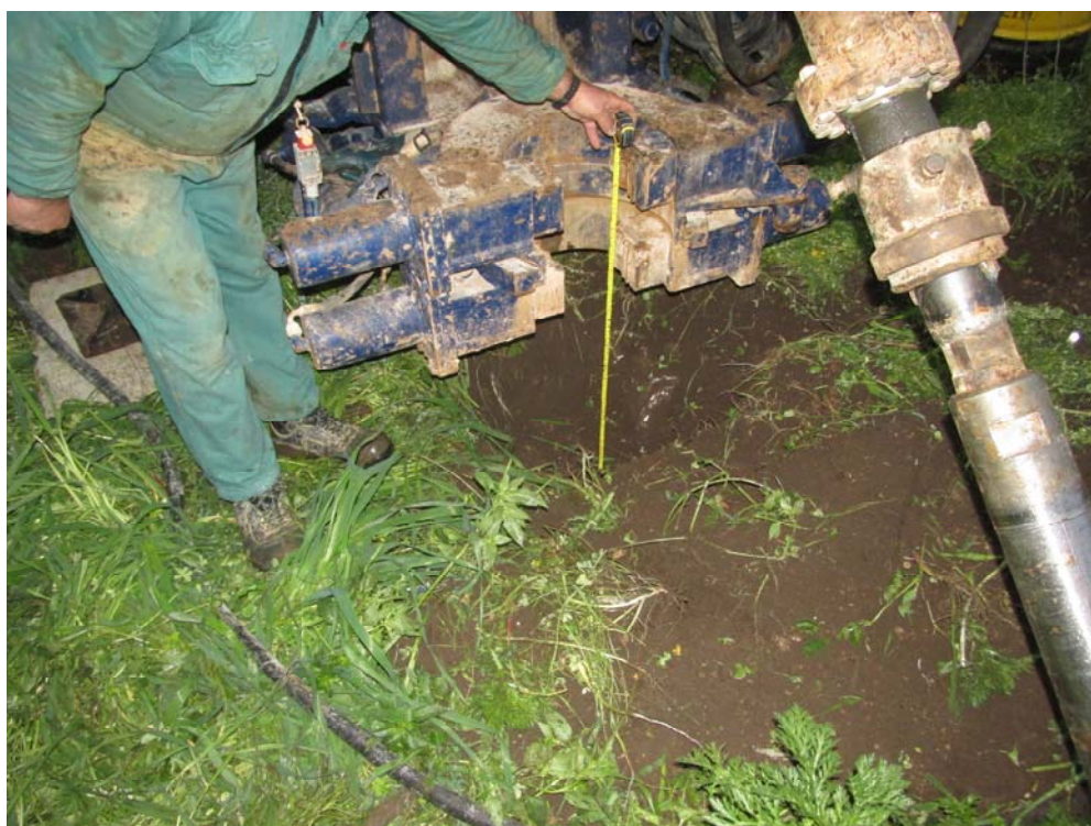
Sondaggio S3: Pre-scavo eseguito a mano
