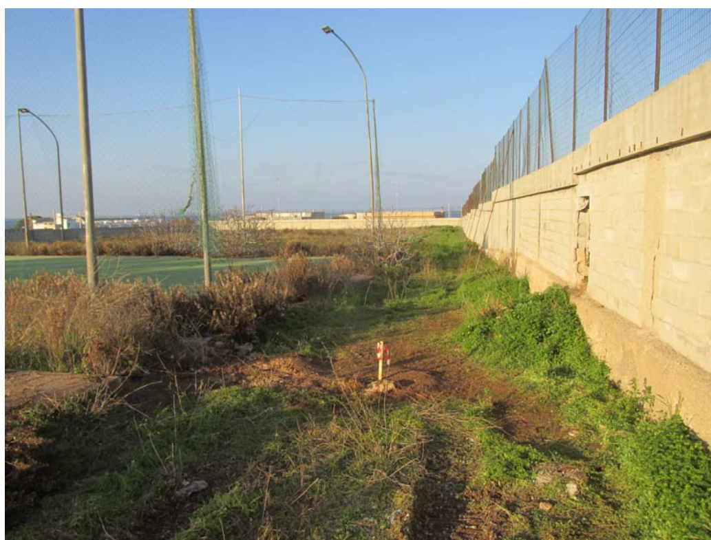
Sondaggio S4: Stato di fatto post-sondaggio
