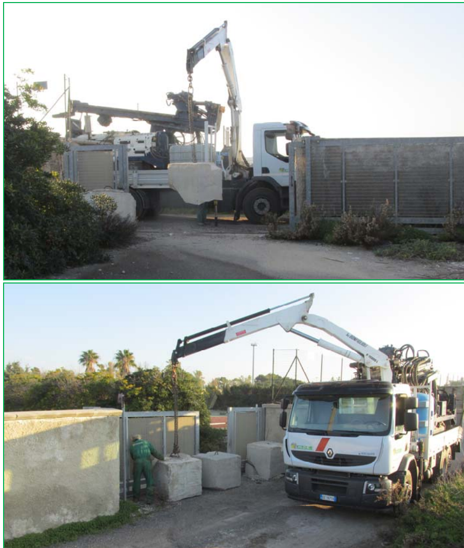
Figura 5: Fase di rimozione blocchi di cemento situati all'ingresso dell'area dei sondaggi S3 e S4.
