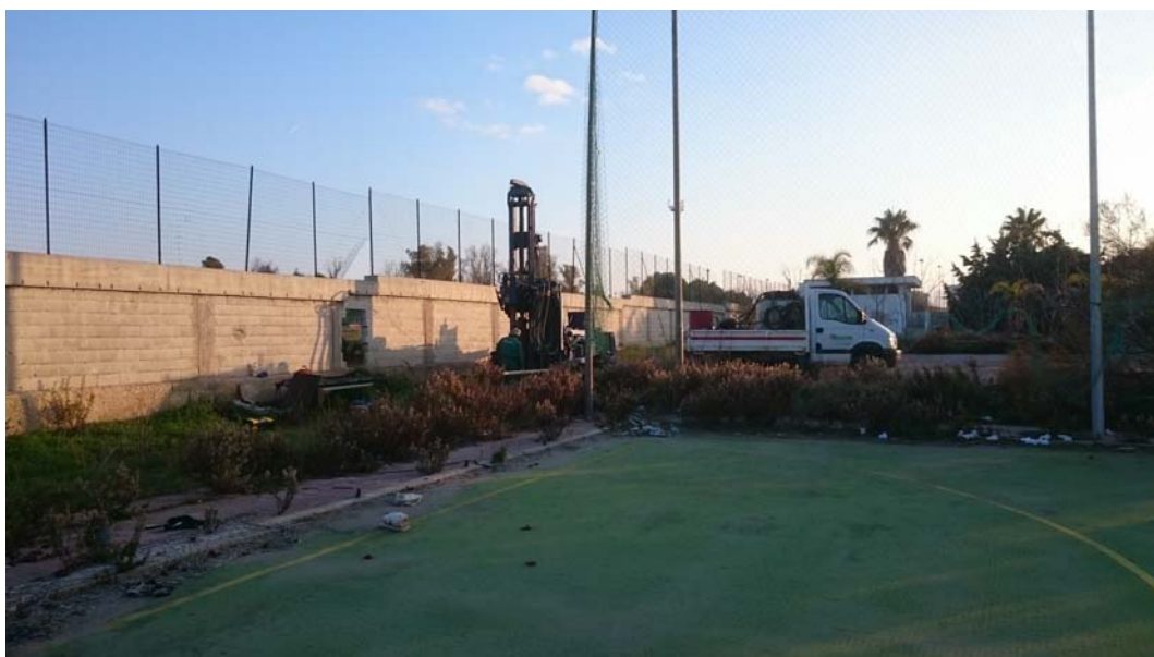
Sondaggio S4: Avanzamento sondaggio
