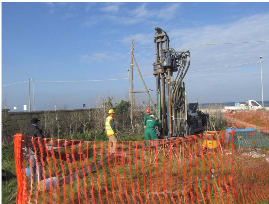
Sondaggio S2: Avanzamento sondaggio
