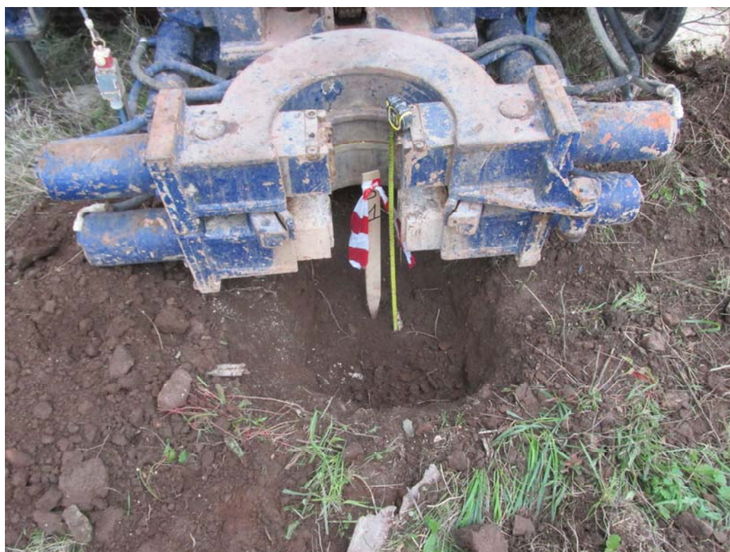
Sondaggio S1: Pre-scavo eseguito a mano
