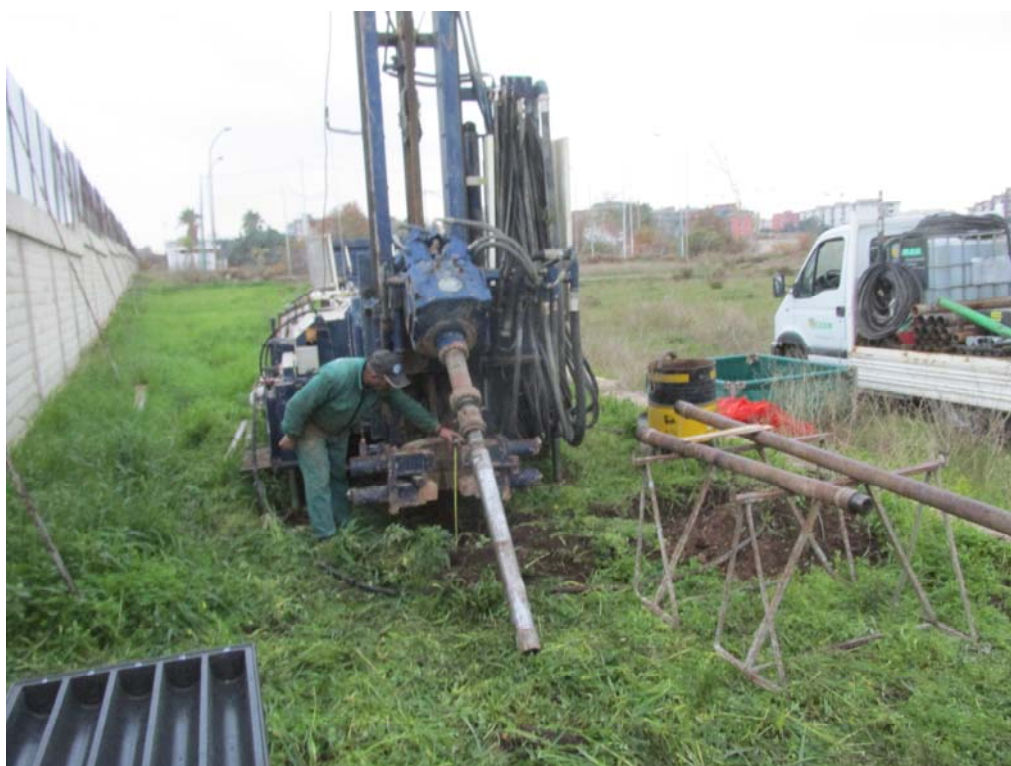
Sondaggio S3: Avanzamento sondaggio
