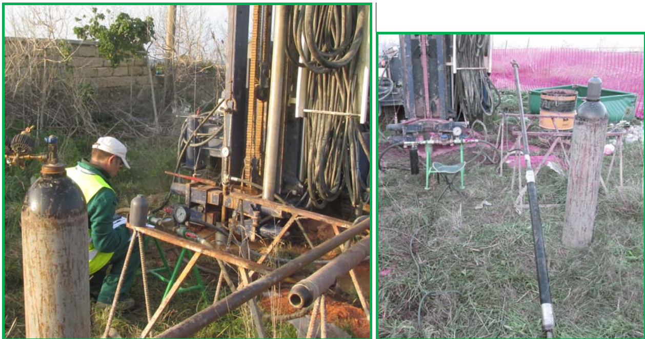
Figura 4: immagine di prova in corso (S1); a destra, otturatore semplice utilizzato.
