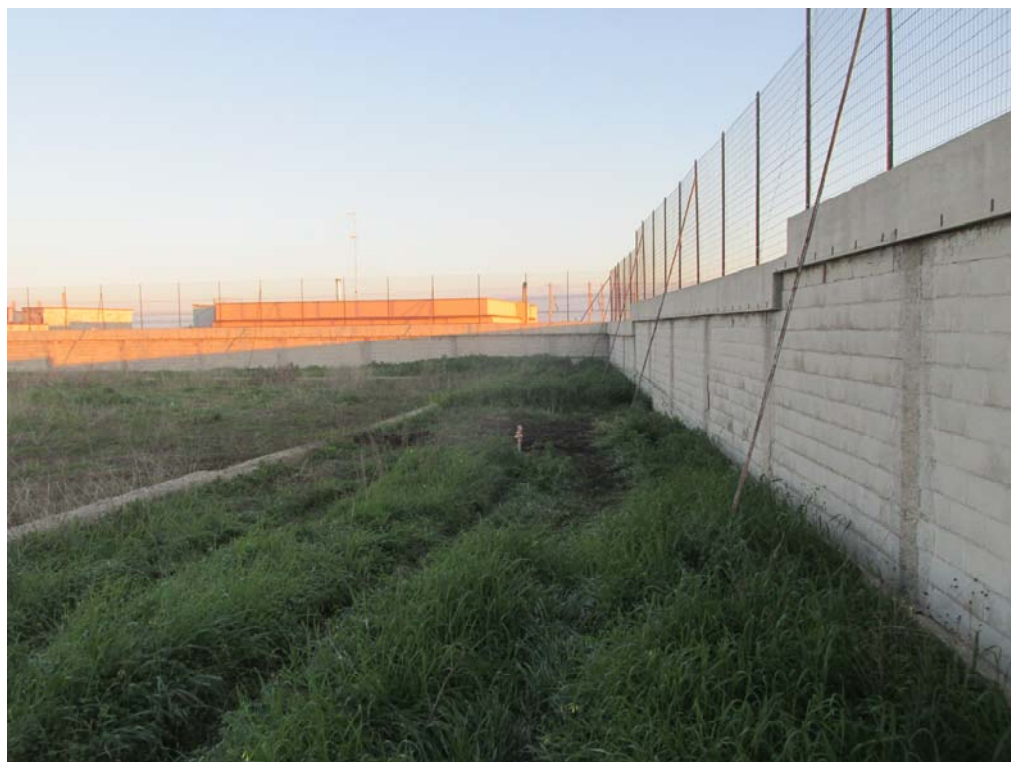
Sondaggio S3: Stato di fatto post-sondaggio
