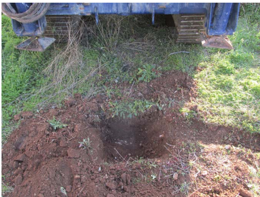
Sondaggio S4: Pre-scavo eseguito a mano
