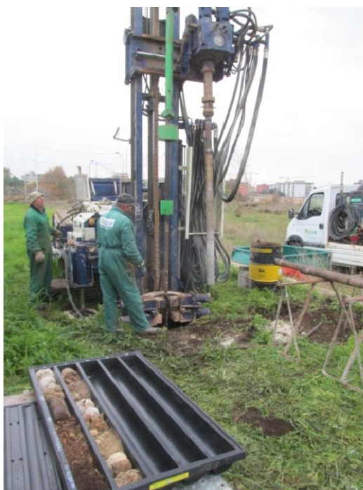
Figura 1: Dettaglio esecuzione prova
