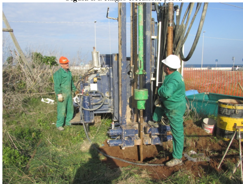
Figura 1: Dettaglio esecuzione prova
