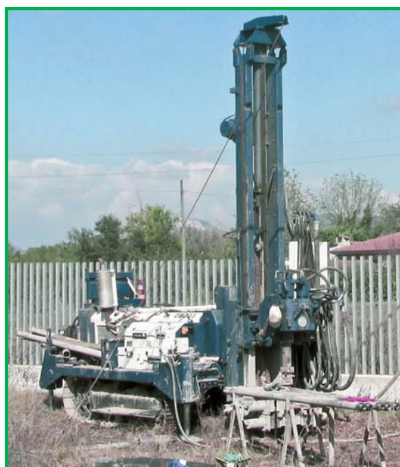
Figura 1: Macchina perforatrice utilizzata.
