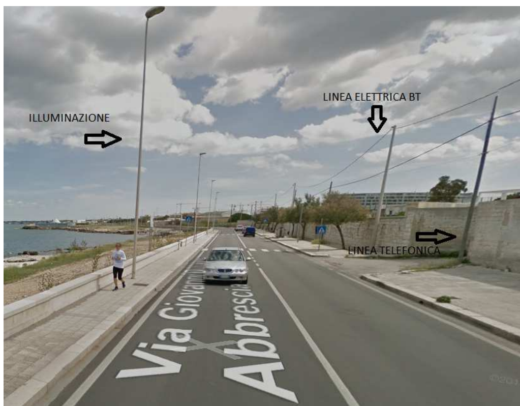
Foto - Linee aeree interferenti
