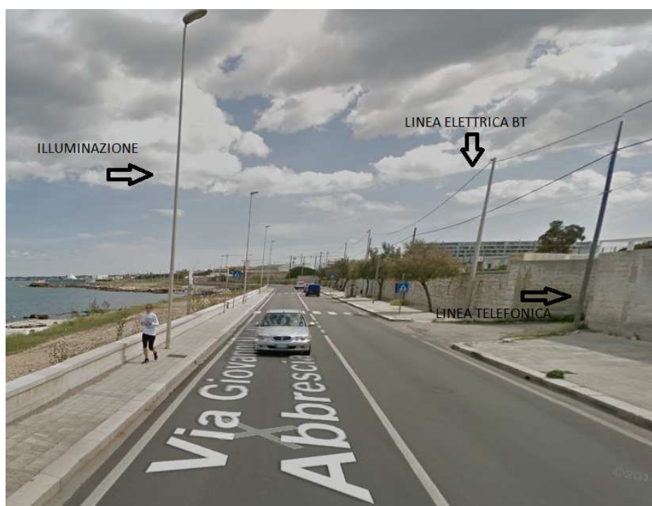
Foto - Linee aeree interferenti
