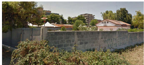
Edificio Residenziale: Strada Rurale Cannone
