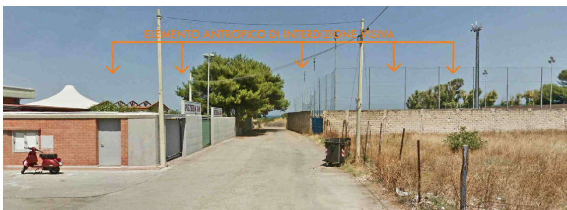
Figura 88 Fotografia dal punto di ripresa fotografica n. 1 con indicazione degli elementi di interdizione visiva
