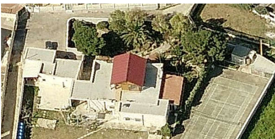
Edificio Residenziale: Strada Rurale Cannone
