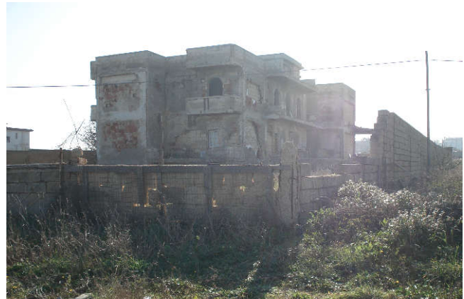
Rudere : Via Giovanni di Cagno Abbrescia
