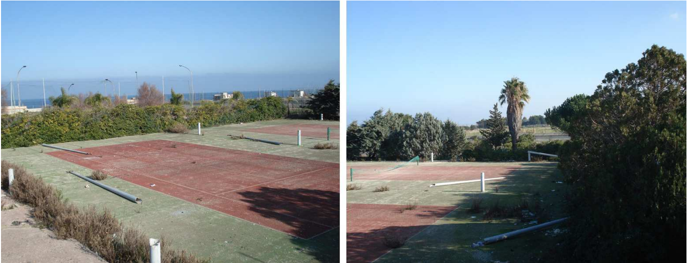
Figure 4-18: Infrastrutture in abbandono.
