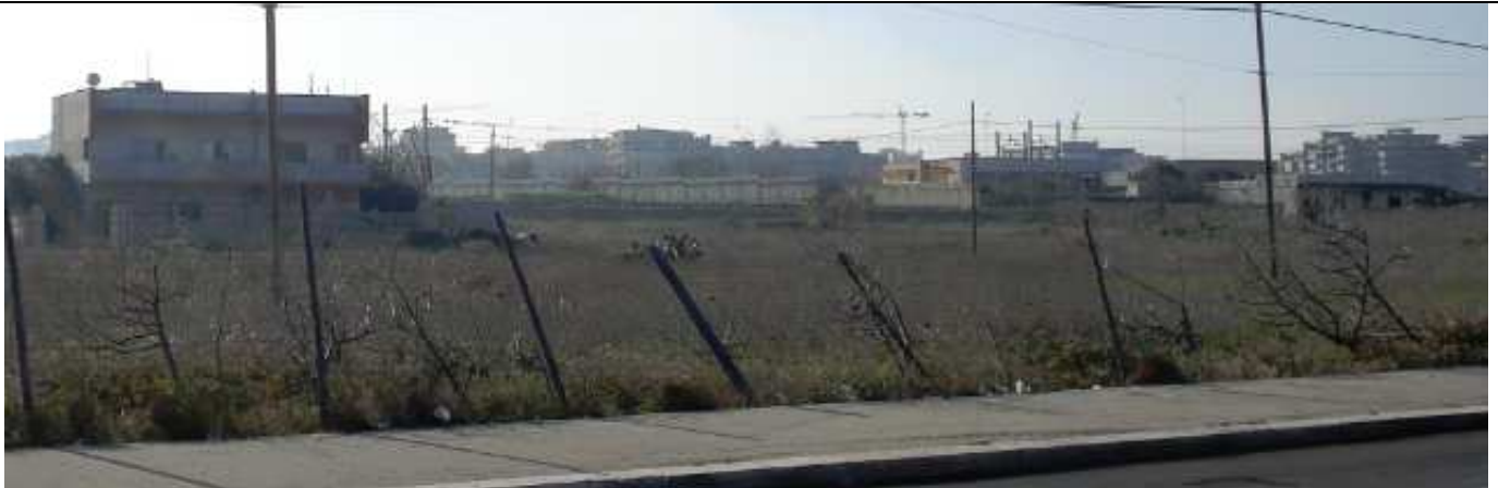
Vista dell'area destinata al cantiere di stoccaggio dalla via Giovanni Di Cagno Abbrescia.
