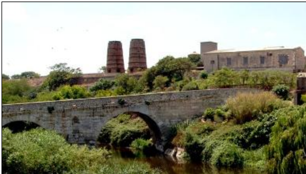
Figura III.42- Ponte Romano sul Rio Mannu
