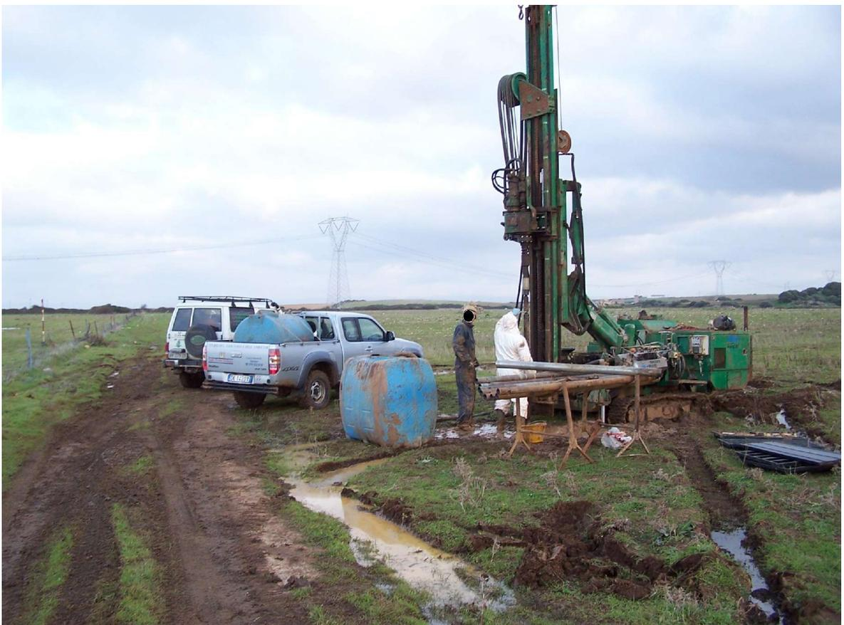
**Foto n° 18 – Particolare dell'esecuzione del sondaggio geognostico S2**
