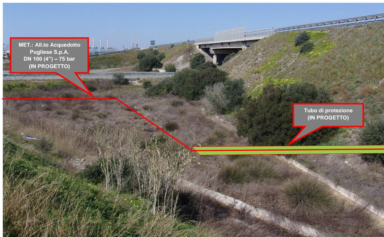
Fig. 3 – Metanodotto e tubo di protezione
