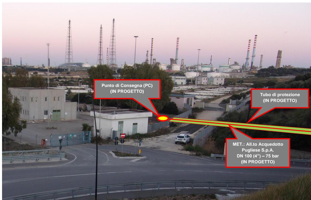
Fig. 4 – Metanodotto con tubo di protezione e Punto di Consegna
