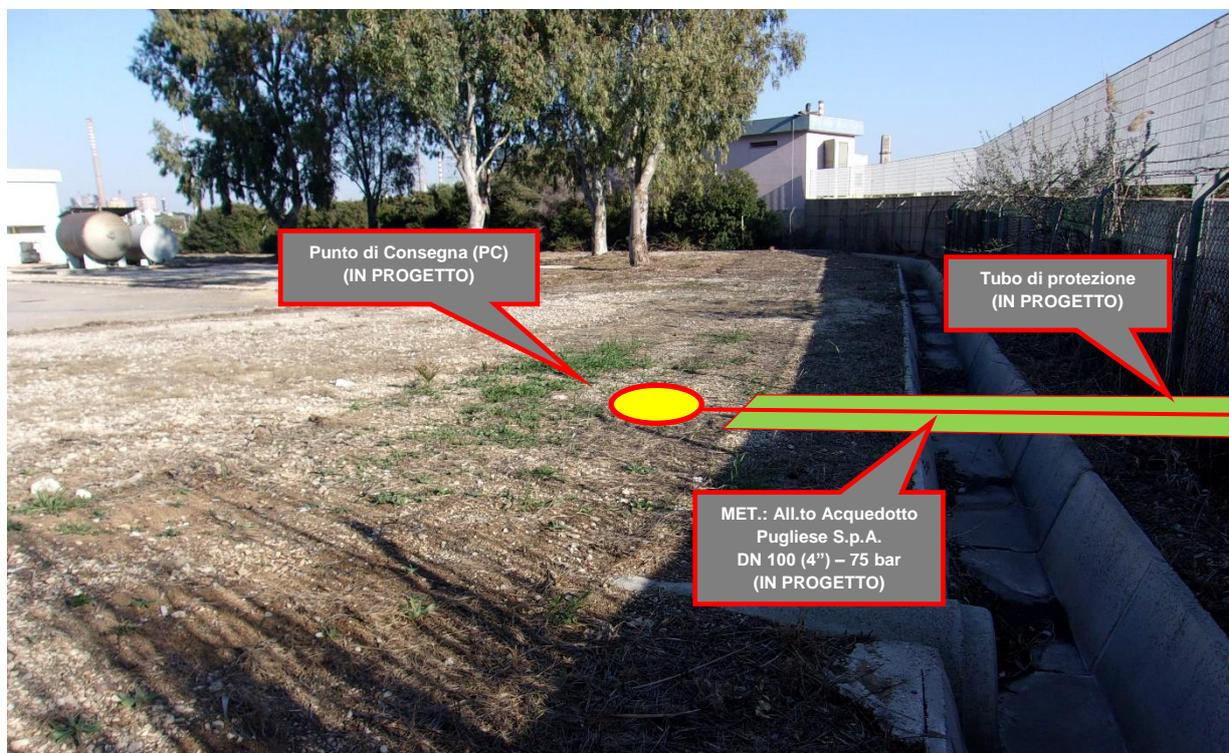
Fig. 5 – Metanodotto con tubo di protezione e Punto di Consegna
