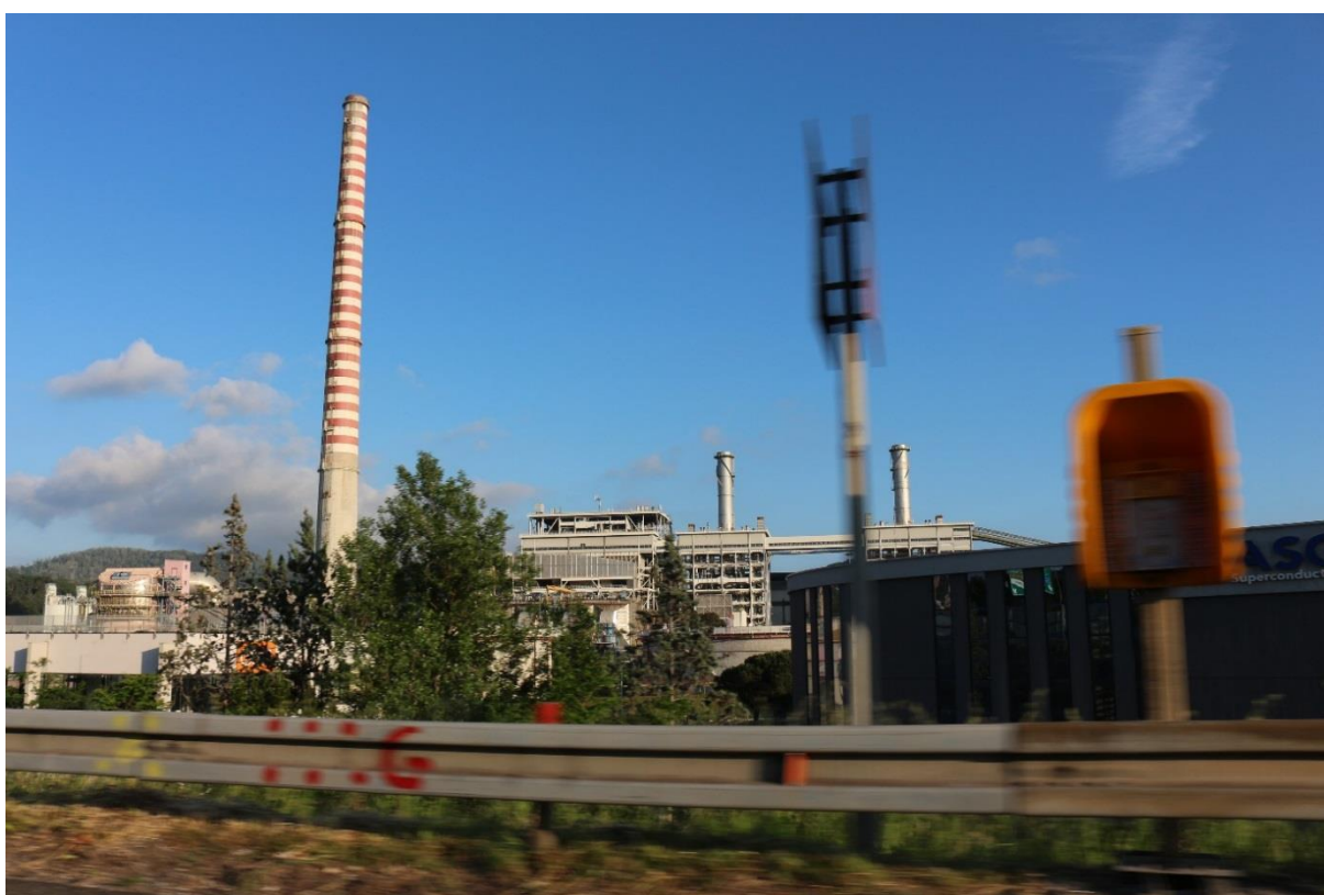
Figura 4.7.9 – Punto di vista 1 – Stato di fatto
