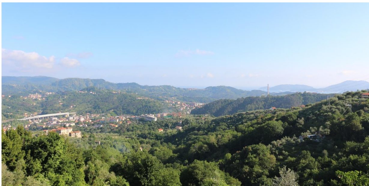
Figura 4.7.19 – Punto di vista 6 – Stato di fatto
