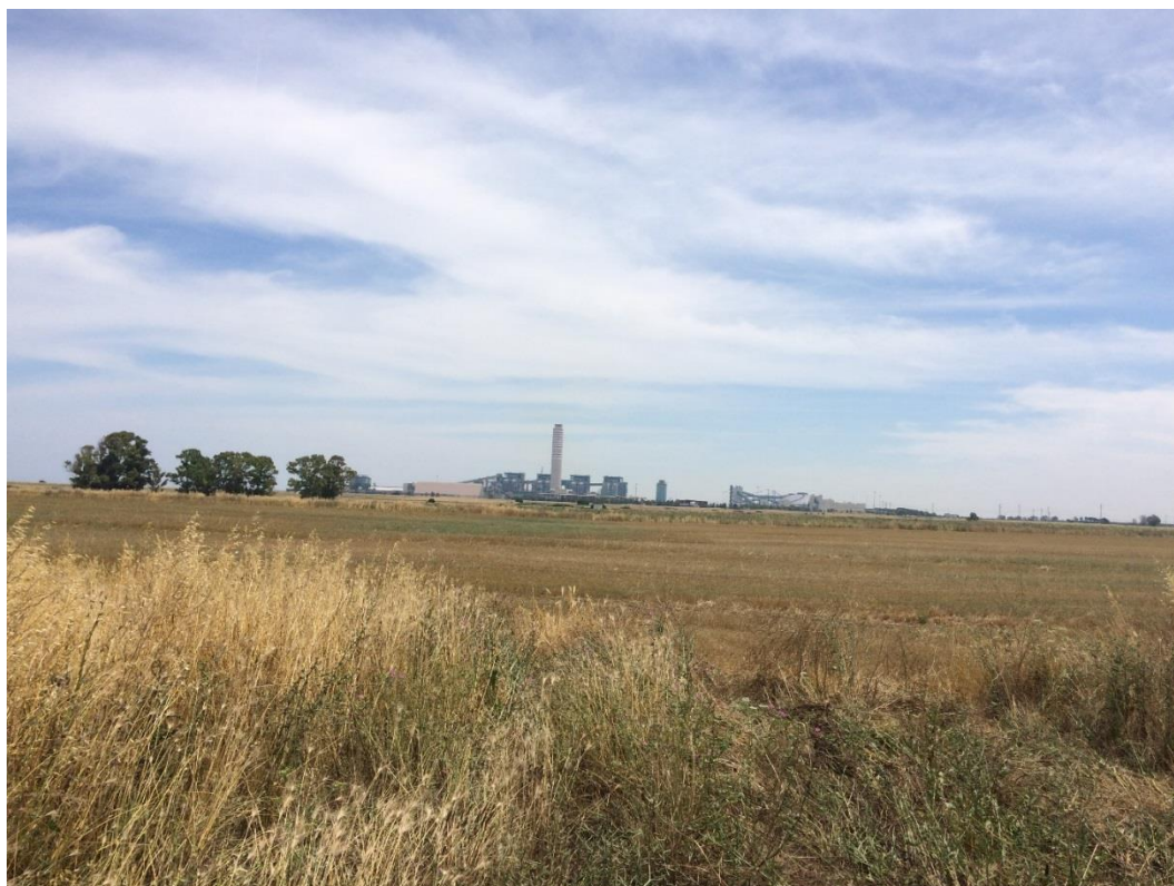
Figura 5.5.7 – Punto di vista 4 – Stato di fatto
