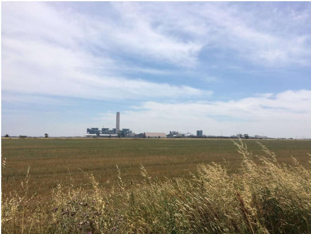
Figura 5.5.13 – Punto di vista 7 – Stato di fatto
