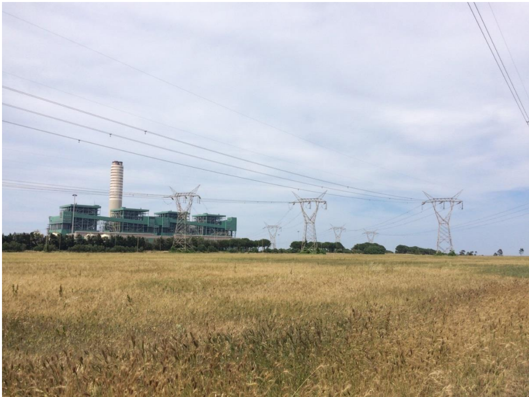
Figura 5.5.3 – Punto di vista 2 – Stato di fatto
