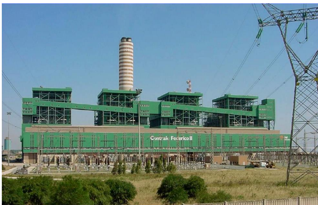
Figura 2.1.1 – Vista della centrale Federico II di Brindisi
