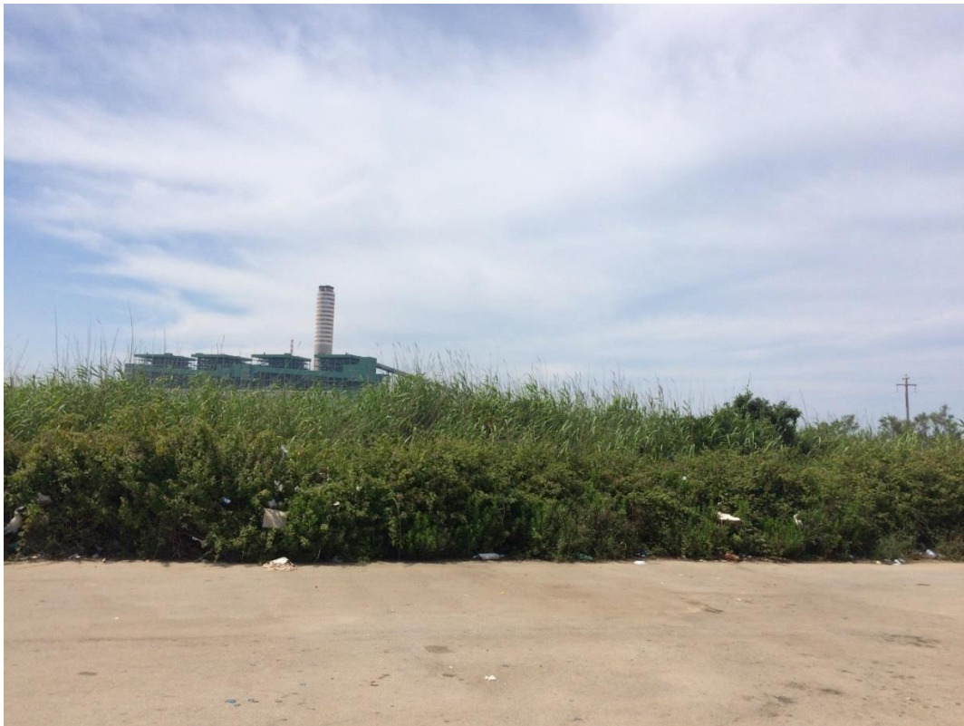
Figura 5.5.1 – Punto di vista 1 – Stato di fatto
