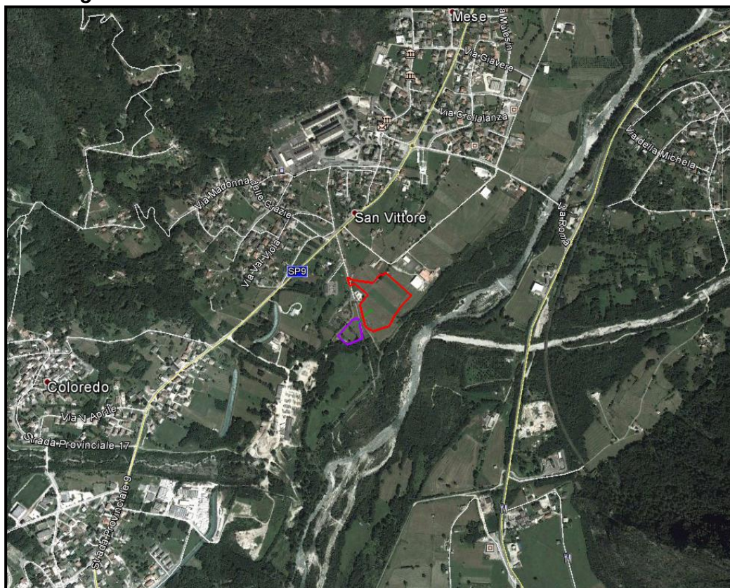
Figura 3.1b Vista Aerea dell'Area Individuata per la Realizzazione del Progetto: Inquadramento di Dettaglio c/o S.E. MESE 380
