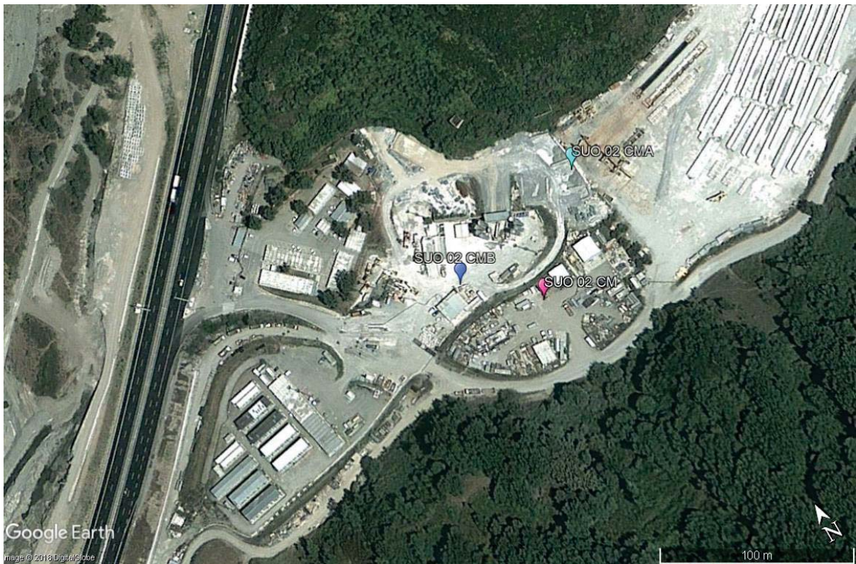
Figura. 2 ubicazione punti monitoraggio su ortofoto 2012 (google earth)- i punti di monitoraggio prescelti ricadono nelle aree di installazione del cantiere.
