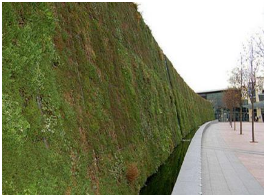
Esempio di muro verde antinquinamento
