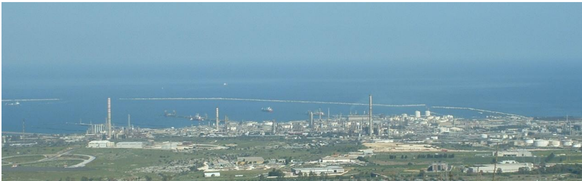
Lato sud del polo petrolchimico, visto dal Comune di Melilli
