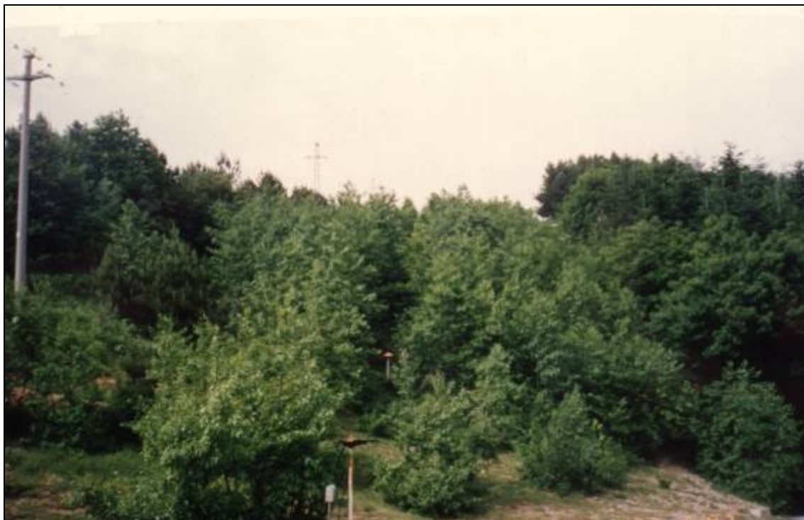
Foto 4.1/A: Metanodotto realizzato nel 1985 - la vegetazione naturale (non sono stati eseguiti ripristini) sta ricoprendo la pista di lavoro del metanodotto
