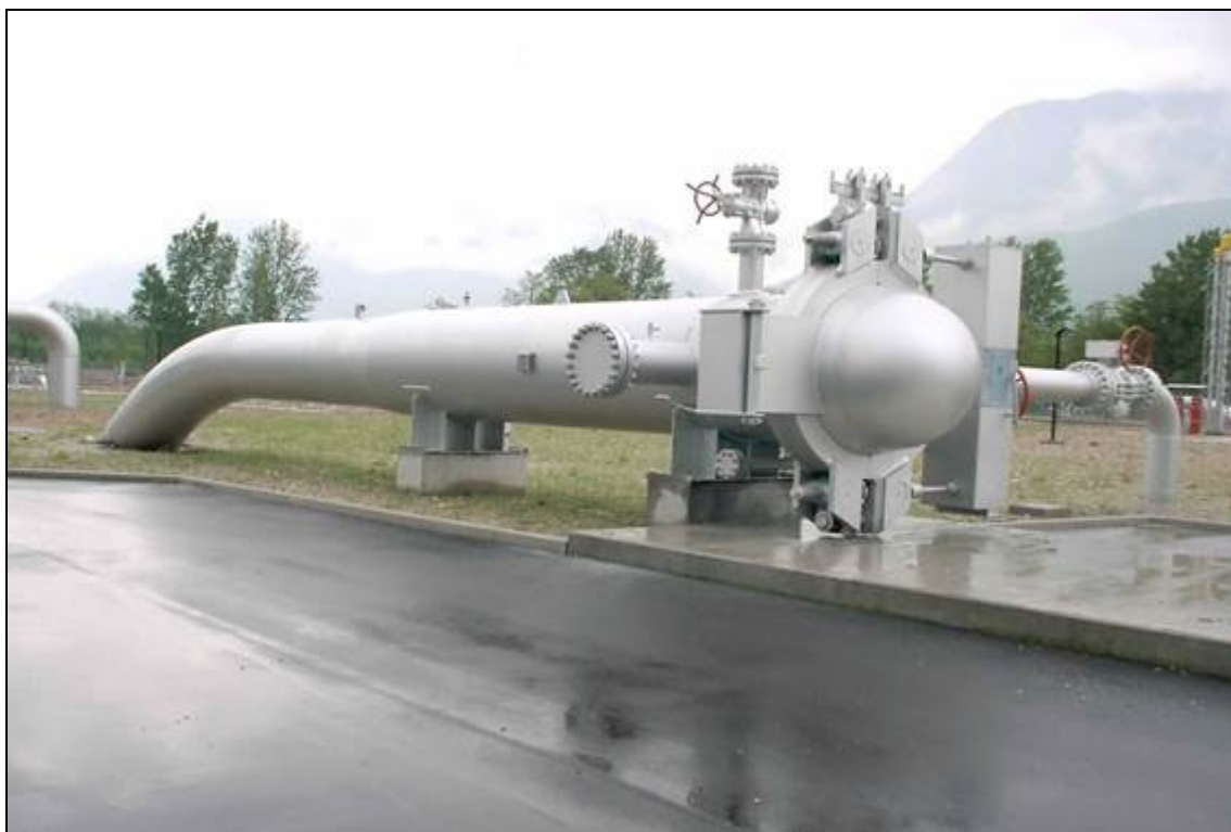
Fig. 2.2/A: Punto di lancio e ricevimento pig
