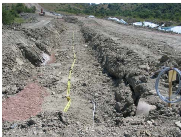
Figura 7 – Rinterro della condotta
