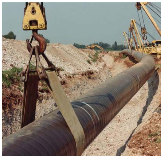
Figura 6 – Posa della condotta
