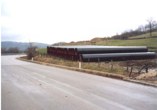
Figura 3 – Piazzola di accatastamento tubazioni
