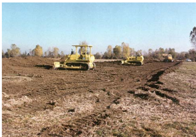
Figura 4 – Apertura della fascia di passaggio
