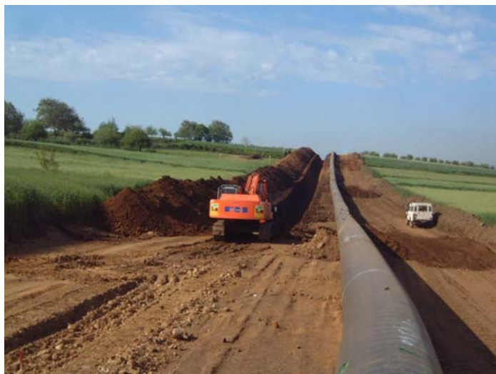
Figura 5 - Scavo in trincea
