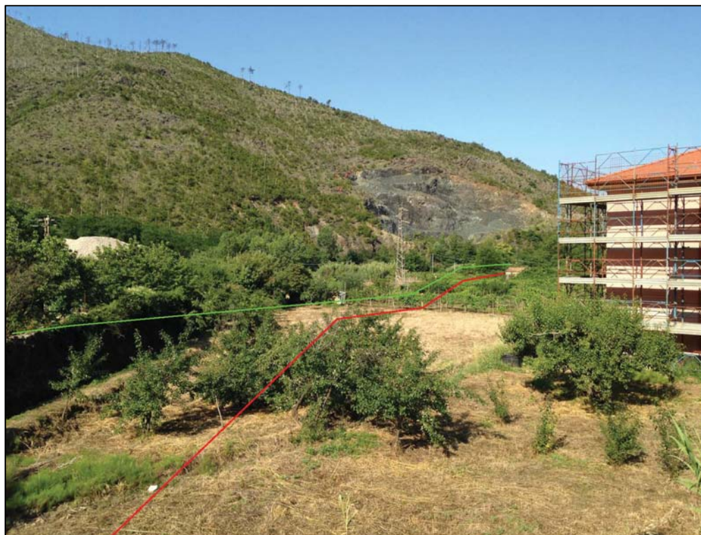
Foto 1: Panoramica senso gas in sponda destra del Torrente Petronio, tratto in parallelo al metanodotto esistente da rimuovere
