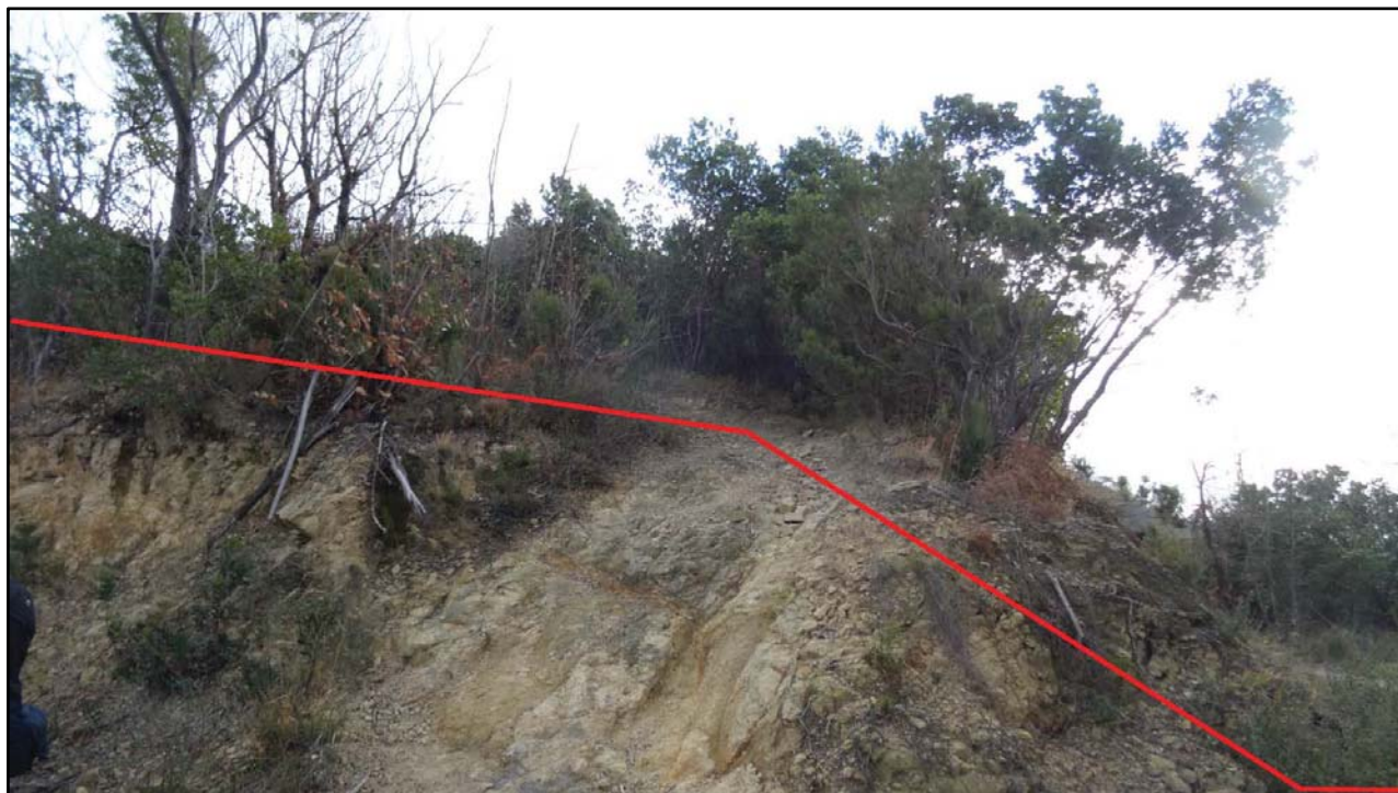
Foto 17: Attraversamento Strada comunale in Località Costa Crocetta
