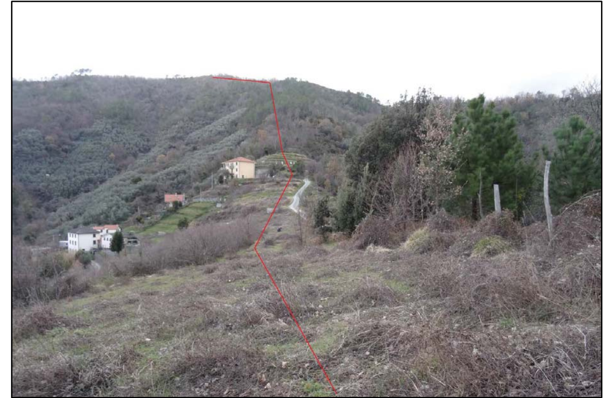
Foto 11: Panoramica senso gas in Località Montedonico e risalita verso Monte Terisso
