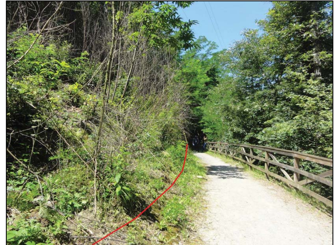
Foto 23: Panoramica senso gas in Località Belvedere
