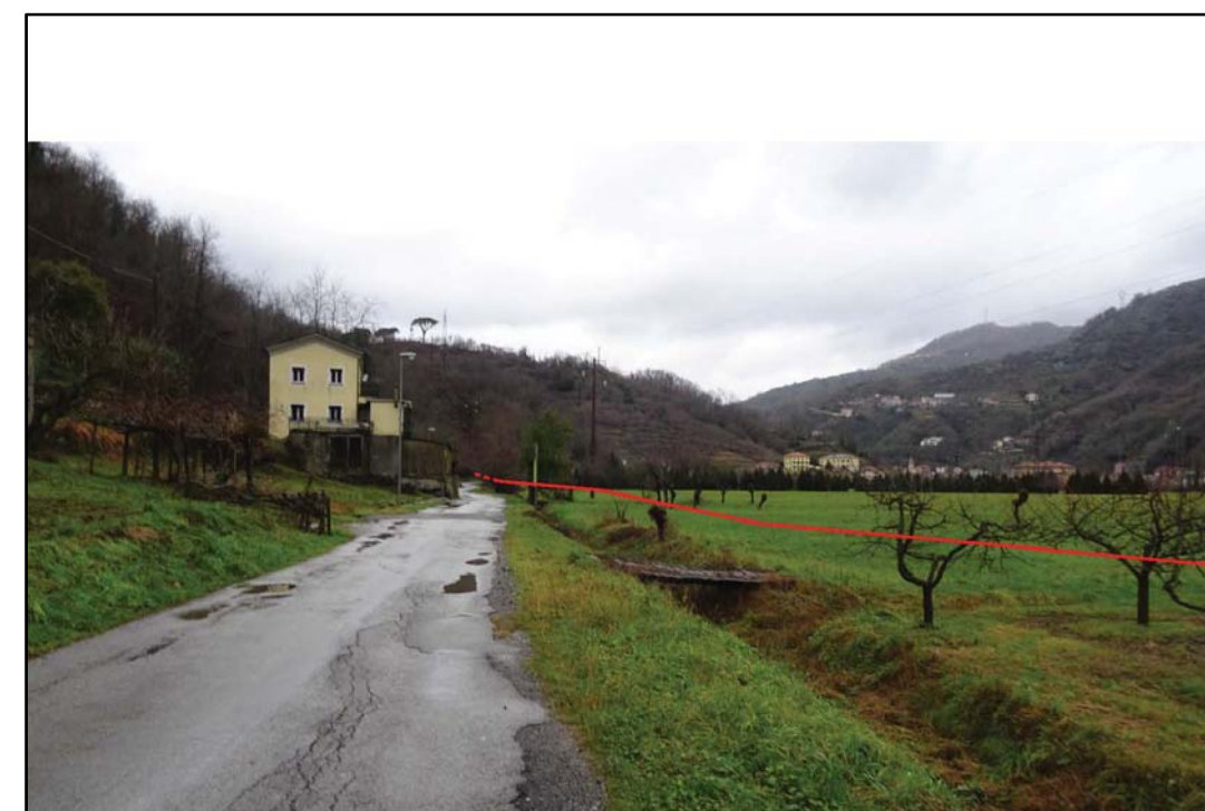
Foto 20: Panoramica senso gas in Località Piano di Seriallo, sullo sfondo il Microtunnel "La Pezza 1"
