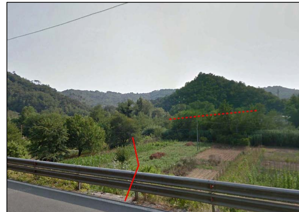
Foto 19: Panoramica senso gas uscita Microtunnel San Martino, attraversamento Torrente Lavagna, sullo sfondo il Microtunnel Casa Romana
