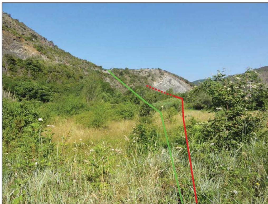
Foto 2: Panoramica senso gas in sponda sx del torrente Petronio. Tratto in parallelo al metanodotto esistente da rimuovere. Sullo sfondo il microtunnel "Pezze"
