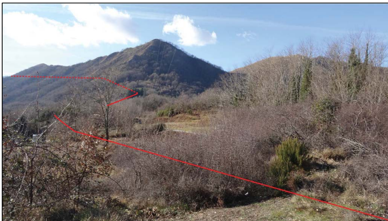
Foto 30: Panoramica senso gas in Località Biola, sullo sfondo la risalita a Monte Bado e Gallerie-Microtunnel Monte Bado
