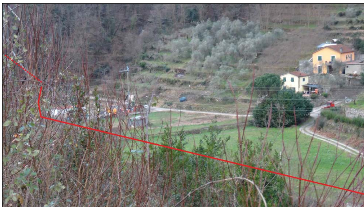
Foto 18: Panoramica senso gas in sponda destra del Torrente Sturla, sullo sfondo imbocco Microtunnel "San Martino"
