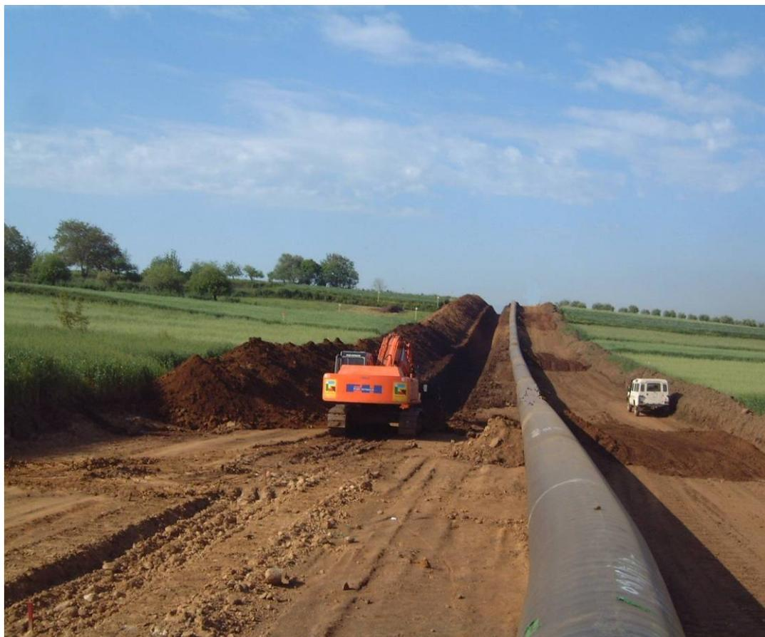
**Foto 2.2/E: Scavo della trincea (esempio di condotta con diametro superiore alla linea in progetto)**
