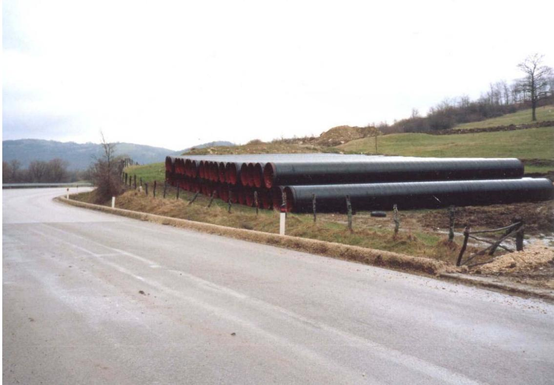
**Fig. 2.2/A: Esempio di piazzola di accatastamento tubazioni (esempio relativo ad altro metanodotto con tubi di diametro maggiore rispetto alla linea in progetto)**
