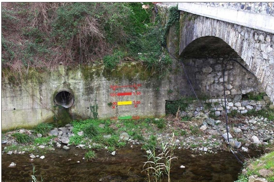
**Foto 3.2/A:** Argine del T. Petronio presso la Stazione di Lancio e Ricevimento PIG di Casarza Ligure. In primo piano le scritte sull'argine che indicano i livelli a diverse pericolosità di piena molto variabili a seguito di eventi meteorici
