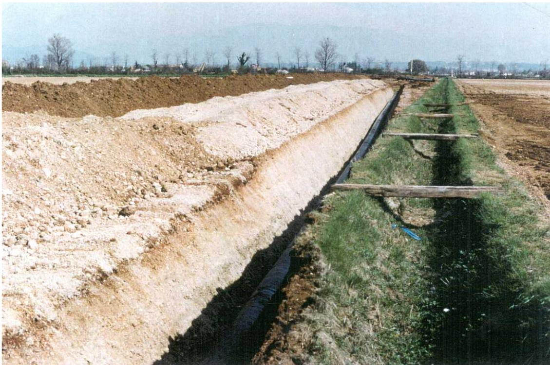
**Foto 2.2/G: Tratto di condotta posata, si nota l'accantonamento dello strato humico separato dal materiale di scavo della trincea**
