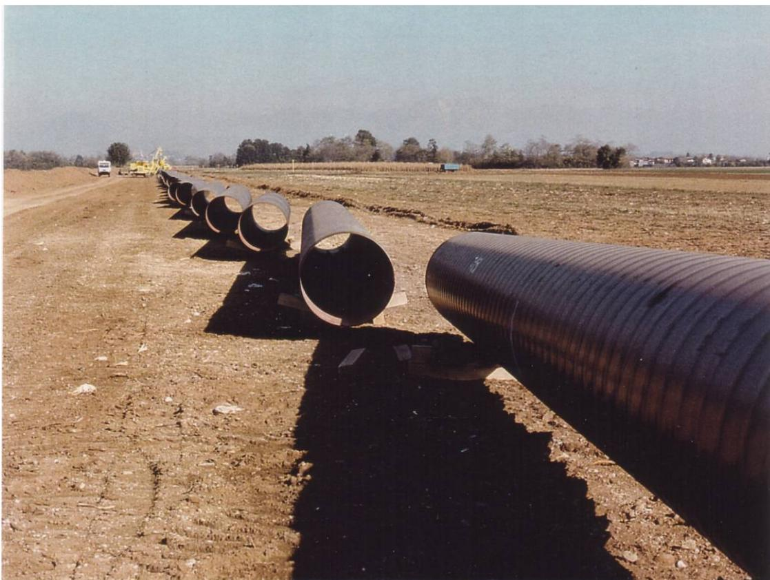
**Foto 2.2/C: Sfilamento tubazioni (esempio di tubi con diametro superiore alla linea in progetto)**
