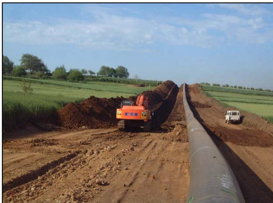
Foto 2.1/C: Scavo della trincea (esempio di condotta con diametro superiore alla linea in progetto)
