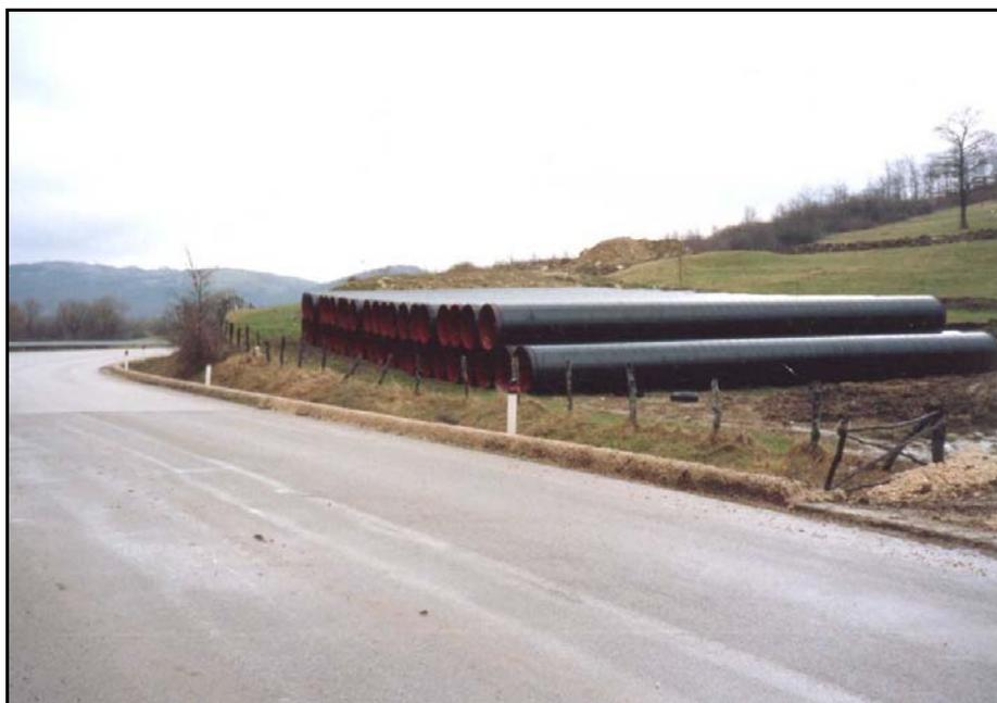
**Foto 2.1/A: Piazzola di accatastamento tubazioni (esempio relativo ad altro metanodotto con tubi di diametro maggiore rispetto alla linea in progetto)**
