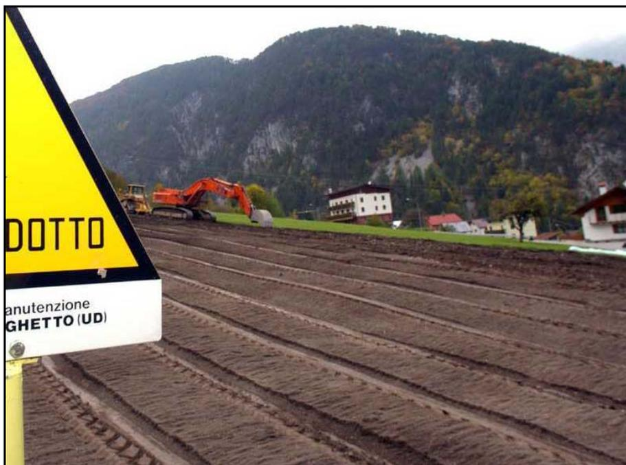
Foto 2.1/F: Distribuzione del topsoil sulla pista di lavoro
