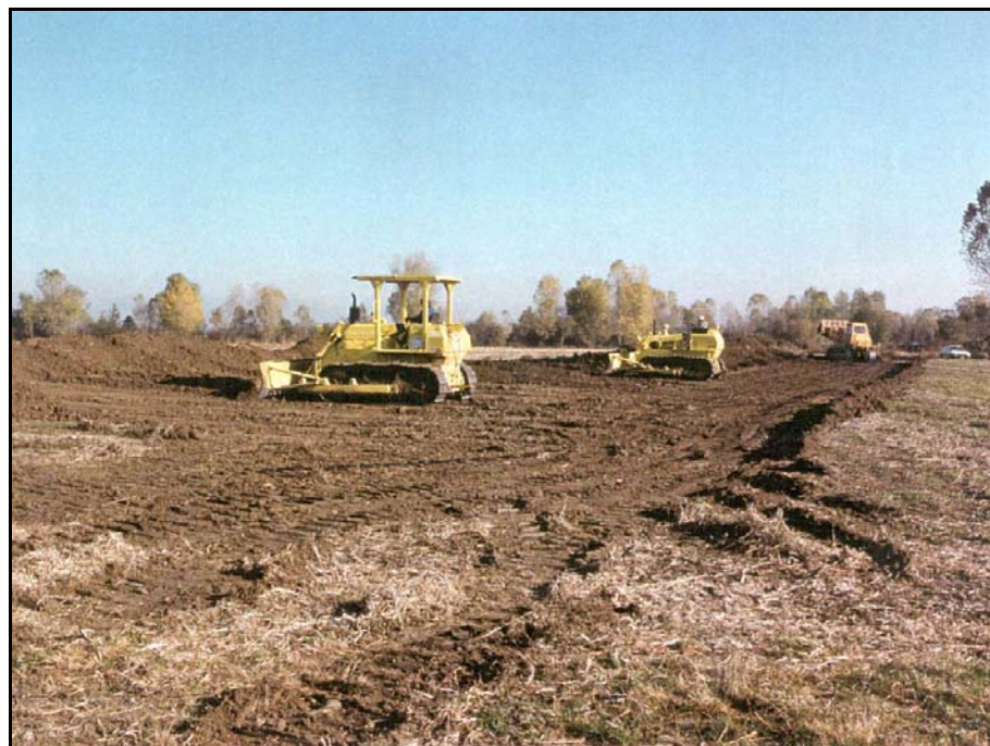
Foto 2.2/B: apertura della pista di lavoro/passaggio
