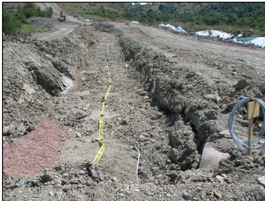
Foto 2.2/E: Rinterro della condotta
