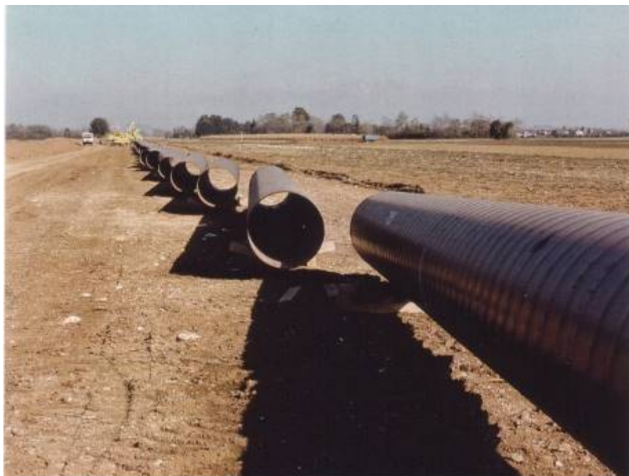
Foto 5/C: Esempio della fase di sfilamento tubazioni (esempio di tubi con diametro superiore alla linea in progetto)
