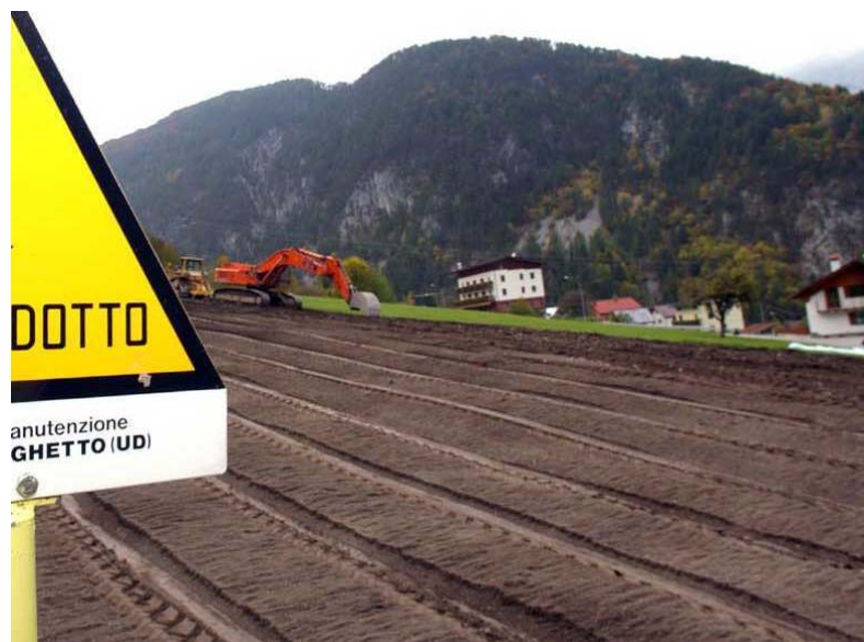
Foto 5/H: Esempio di redistribuzione dello strato superficiale di suolo (topsoil)
