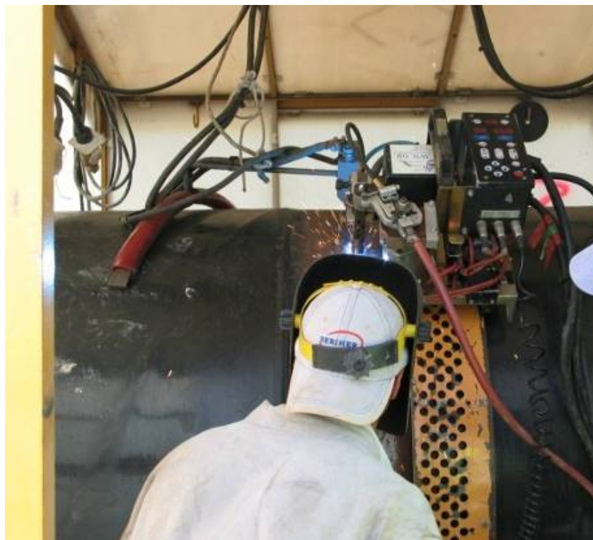
Foto 5/D: Esempio di saldatura di linea
