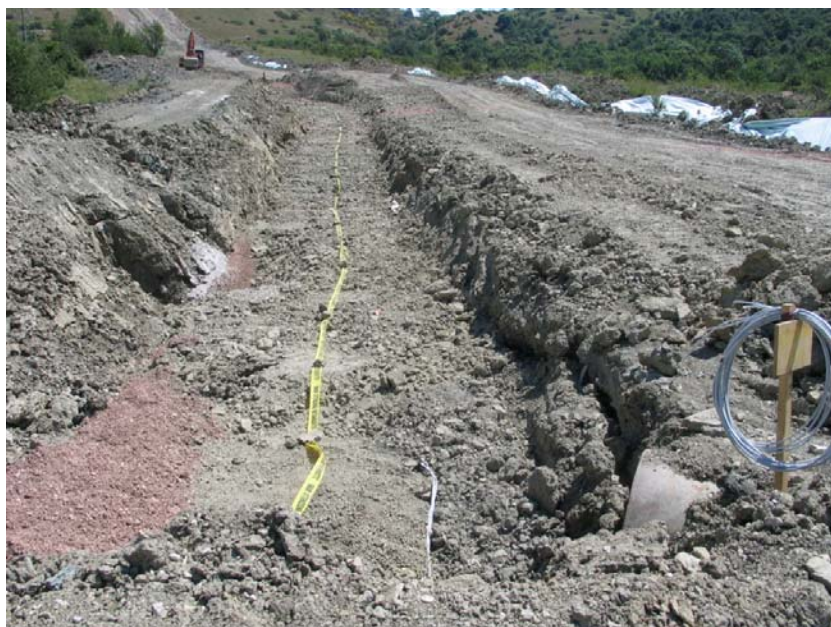
Foto 5/G: Esempio di rinterro della condotta
