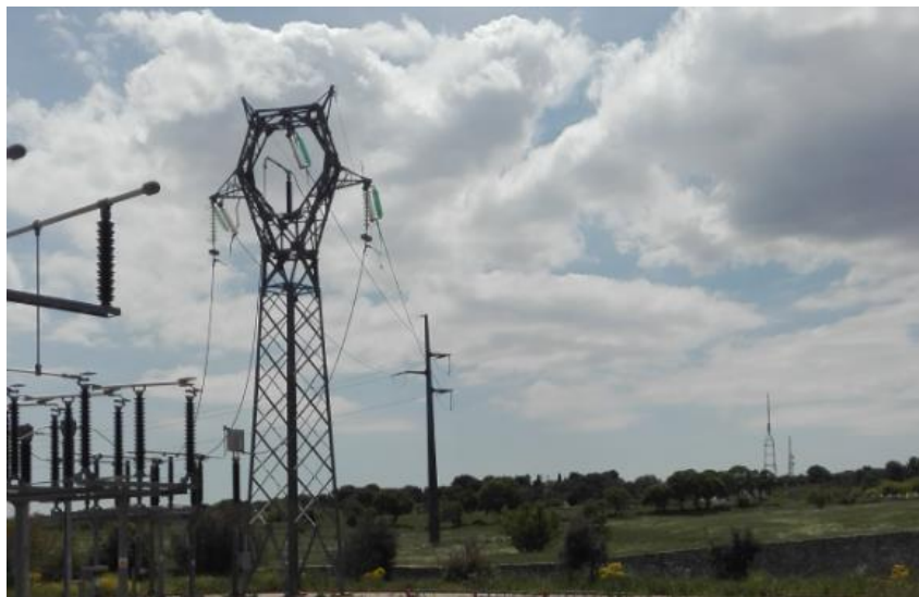
Figura 16: Area SSE di Martina , con di Pali gatto linee aeree e varie infrastrutture
