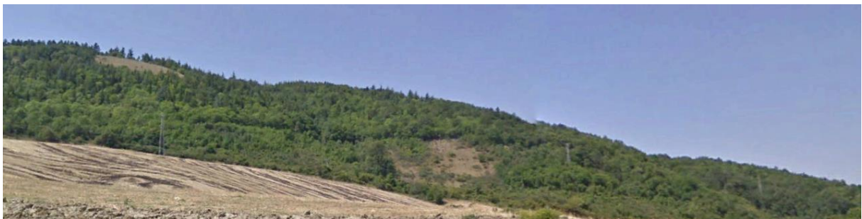
Figura 7: l'immagine mostra il passaggio di una linea elettrica in un bosco – Considerata la trasparenza dei tralicci e la fitta vegetazione, l'alterazione percettiva del contesto appare nulla
