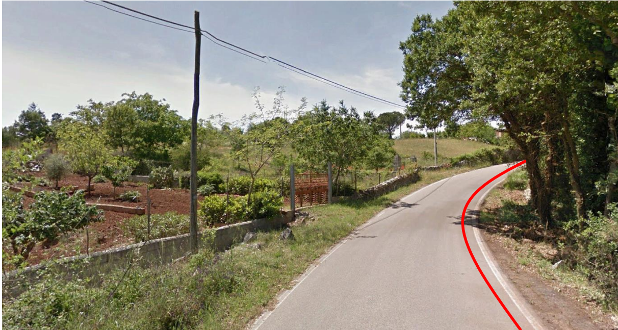
Figura 25 – Ripresa fotografica, con indicazione del tracciato del cavidotto (non si rileva presenza di attraversamenti idraulici)
