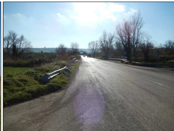
14. Elettrodotto lungo la SP 109, località Villa Merlino
