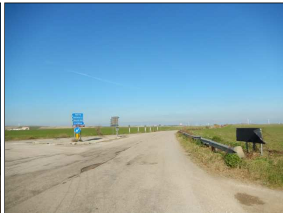
16. Elettrodotta lungo la SP 109, località Cuparone
