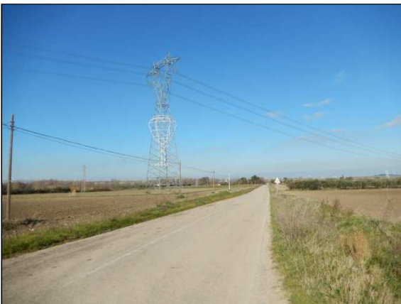
13. Elettrodotto lungo la SP 109, località Casa Lupoli
