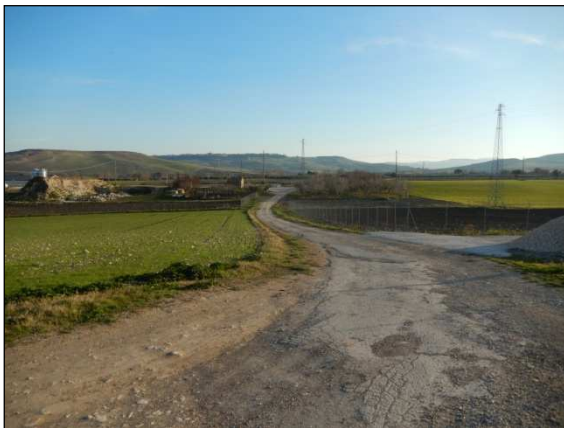
66. Elettrodotta lungo la Strada Comunale Santa Maria, in direzione della SP 125, località Mass. Pirro
