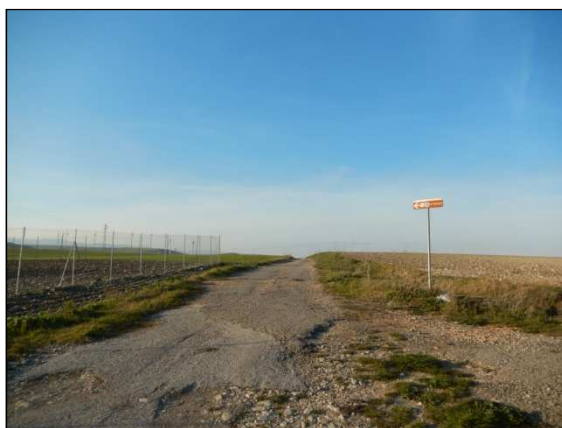
67. Elettrodotta lungo la Strada Comunale Santa Maria, in direzione della turbina 9, località Mass. Pirro
