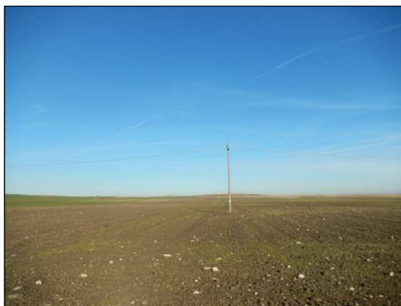
44. Elettrodotto interno in direzione della turbina 1, località Montaratro
