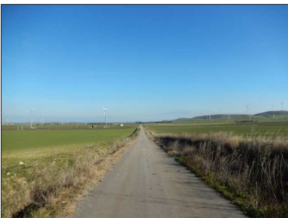
6. Elettrodotto lungo la Strada Comunale Torre Bianca, località Staffio
