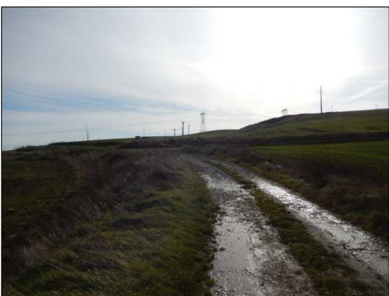
113. Elettrodotto in località Cas. Messina , in direzione della stazione elettrica
