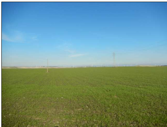
54. Elettrodotto interno in direzione della turbina 11, località Porta di Ferro
