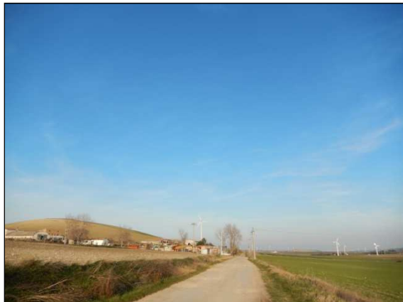
65. Elettrodotta lungo la Strada Comunale Serra Traversa, località Mass. Pirro
