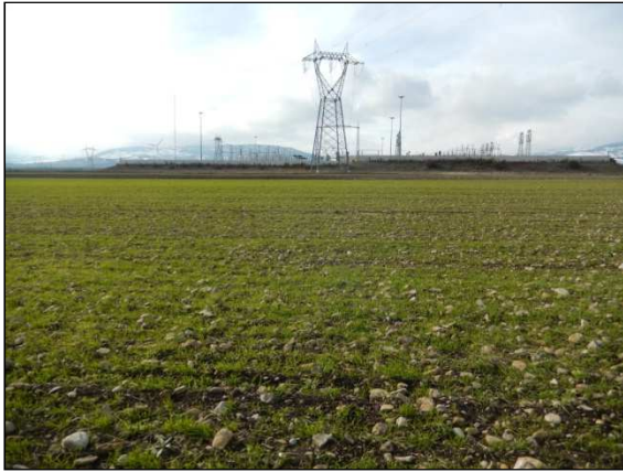
115. Area sottostazione, località Monsignore
