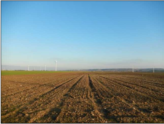
36. Elettrodotto interno in direzione della turbina 3, località Montaratro di sotto
