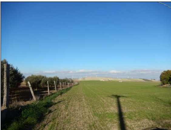
23. Elettrodotto interno in direzione della turbina 12, località Mass. Cuparoni
