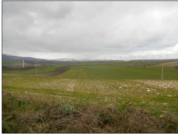
81. Elettrodotta interno in direzione della turbina 22, località Santissimo
