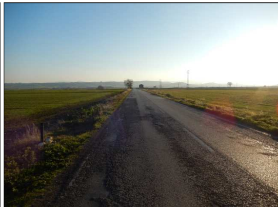
35. Elettrodotto lungo la SP 109, località Montaratro di sotto
