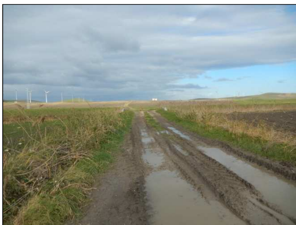
70. Elettrodotta lungo la Strada Comunale Santa Maria, in direzione della turbina 9, località Mass. Pirro
