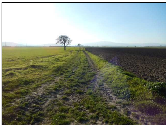
27. Elettrodotto lungo la Strada Vicinale Tavernazza, località Casa Pirro
