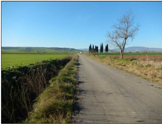
1. Elettrodotta lungo la Strada Comunale Torre Bianca tra le turbine 18 e 19, località Staffio
