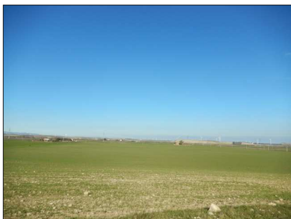
7. Elettrodotto in direzione della turbina 23, località Staffio
