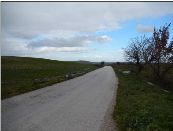
86. Elettrodotto lungo la SP 125, località Bosco dei Santi
