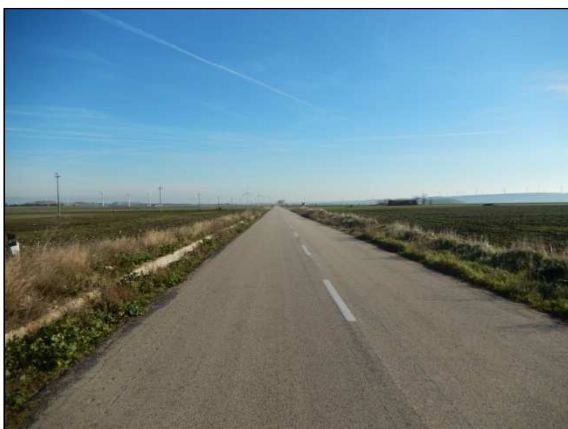
43. Elettrodotto lungo la SP 132, dalla turbina 1 in direzione della SP 109, località Montaratro
