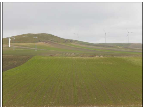
79. Area di installazione della turbina 21, località Santissimo
