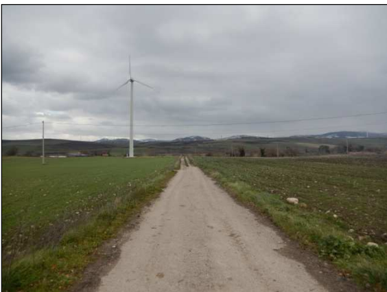
87. Elettrodotto da SP 125 in direzione di Casa Tursi
