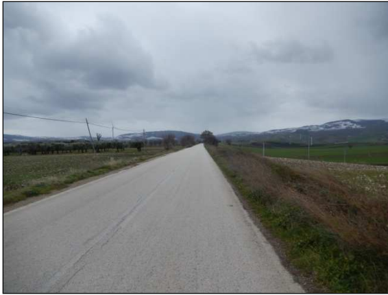
80. Elettrodotta lungo la SP 125 dalla turbina 21 in direzione della turbina 22, località Santissimo
