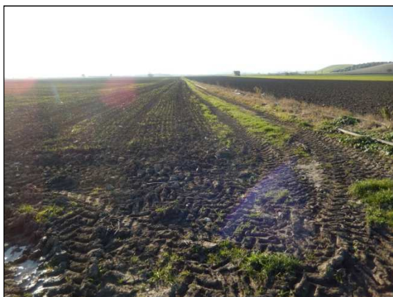
29. Area di installazione della turbina 14, località Casa Marucci
