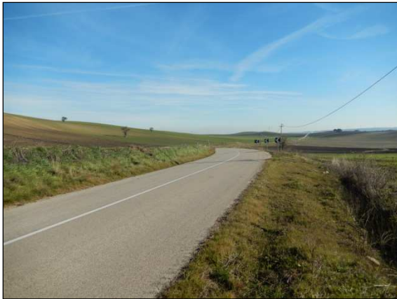
49. Elettrodoto lungo la SP 132, dalla turbina 5 in direzione della turbina 6, località Mass. Petitti
