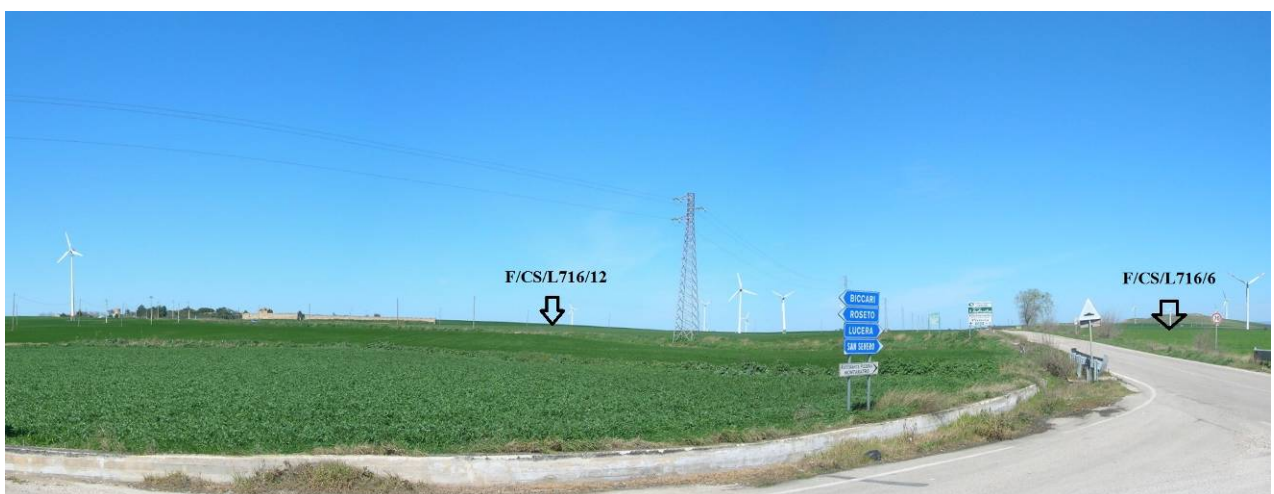
Foto P1.1: Vista dell'incrocio della Sp109 e la SP132, a sinistra l'area di installazione della WTG2 e dietro nello sfondo la Masseria Montaratro, accanto alla masseria a destra l'impianto fotovoltaico esistente F/CS/L716/12, oltre la SP109 l'impianto F/CS/L716/6 (ENTRAMBI NON VISIBILI) (cfr. EOL-SIA-03)
