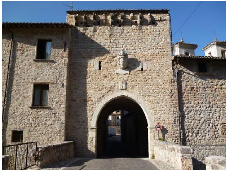
Figura 6: Porta Pontelato prima del sisma del 2016.
