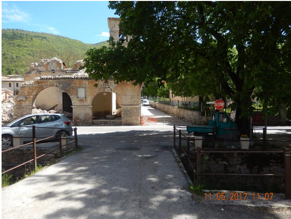
Figura 25: ponte Fosso della Rota su strada comunale del Poggio
