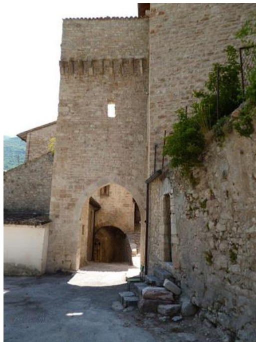
Figura 7: Porta Pontelato prima del sisma del 2016.
