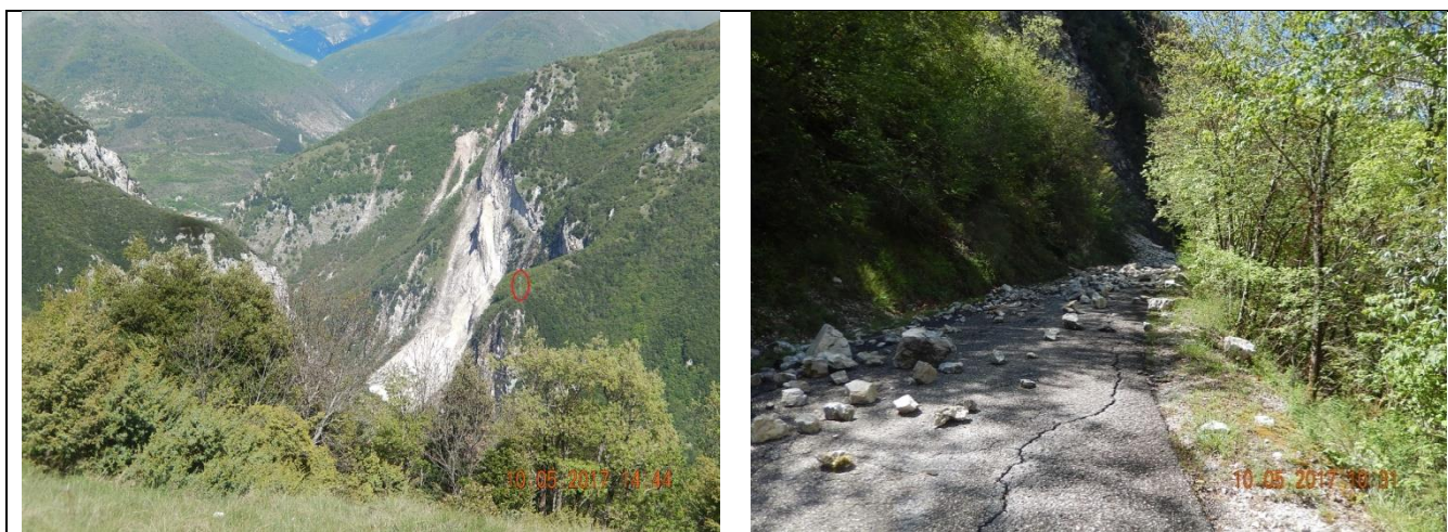
Figura 1:Frana in prossimità della linea Preci-Visso esistente
