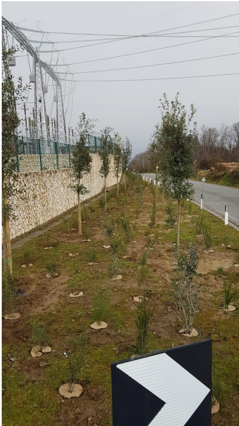
Figura 8 – completamento delle operazioni di impianto con posa dei dischi pacciamanti
