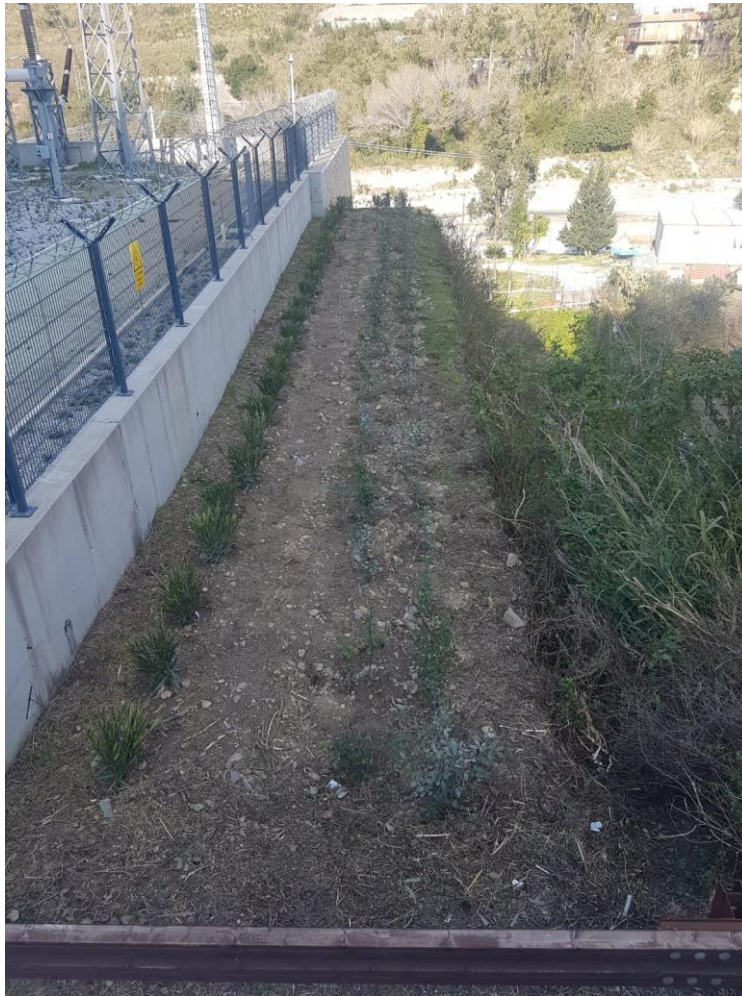
Figura 14 – sistemazione della sommità della terra armata (area 3)
