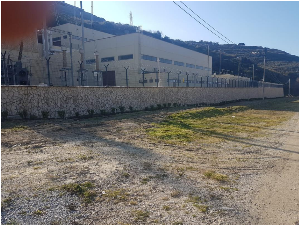
Figura 13 – siepe di oleandro per la schermatura del muro di contenimento della stazione (area 4)
