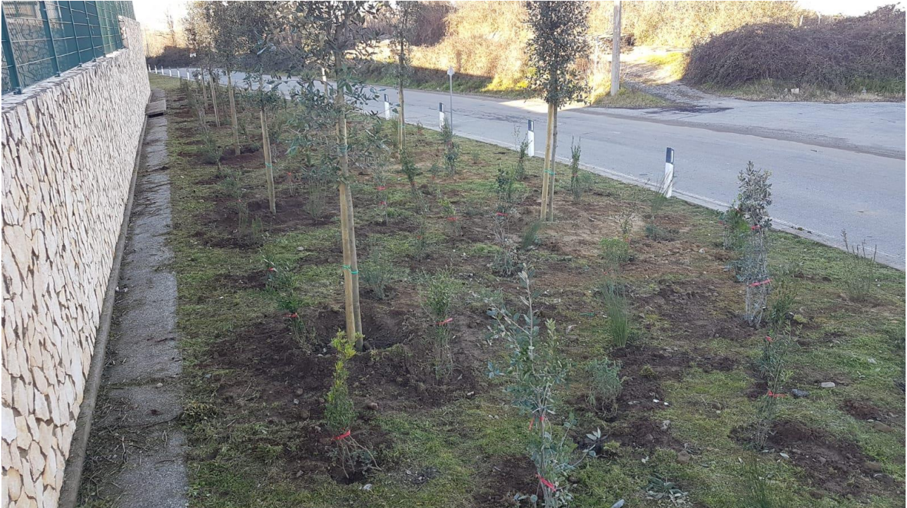
Figura 7 – esecuzione dei lavori di impianto della siepe plurispecifica
