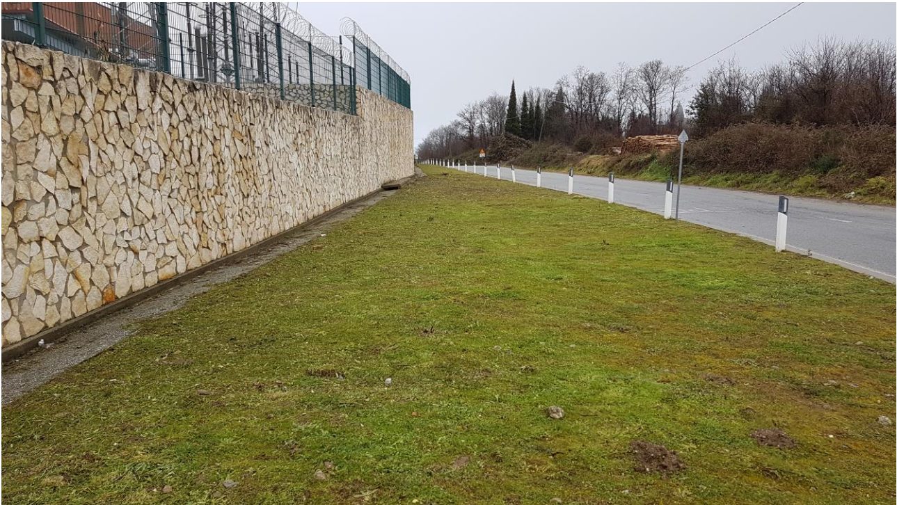
Figura 5 – area presente sul lato est prima dei lavori
