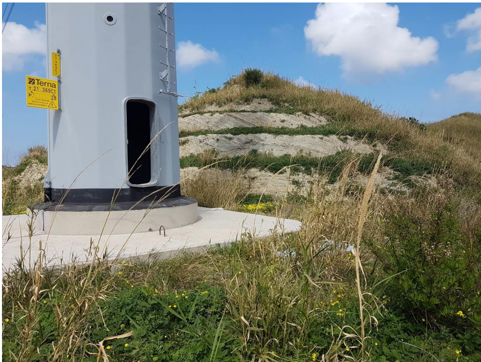
Figura 1 - esempio di inerbimento naturale sviluppatosi spontaneamente riscontrato prima dell'avvio dei lavori di messa a dimora delle piante
