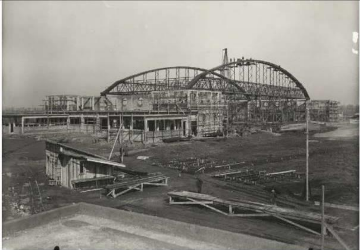
Fig. 1 1937 - Lavori di costruzione - fronte Est (SIRBeC scheda AFRLIMM - IMM-5w060-0008991)
