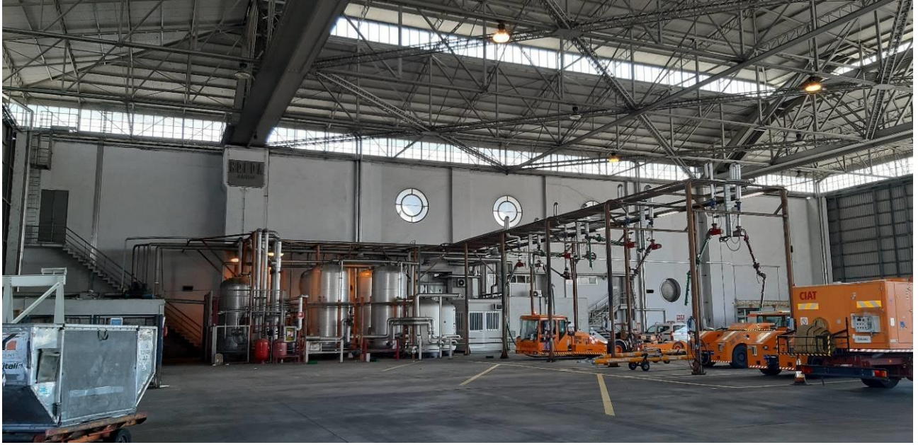
Fig.23 Oggi - Vista interna lato Sud
