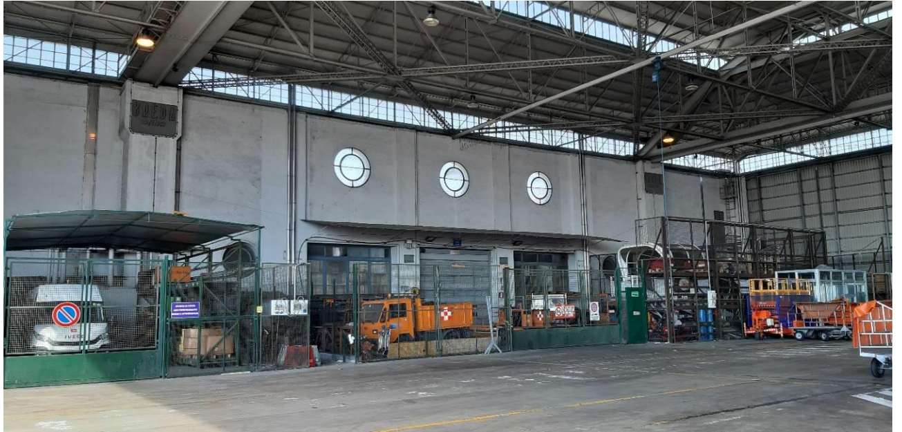
Fig.24 Oggi - Vista interna lato Nord
