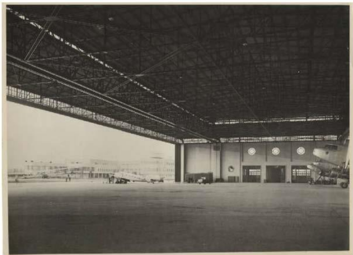
Fig.6 anni '50 – Vista interna verso il piazzale aeromobili (SIRBeC scheda AFRLIMM - IMM-5w060 - 0008995)
