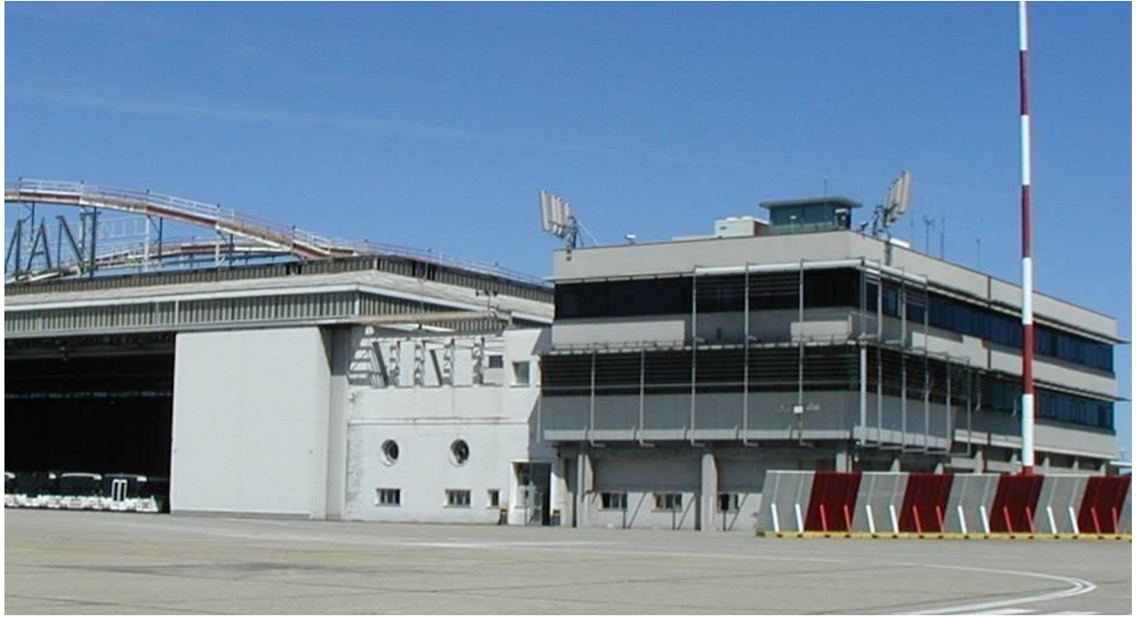
Fig.15 Oggi – Appendice Sud –fronte Ovest
