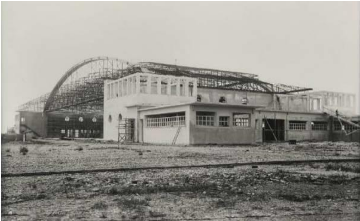
Fig.2 1937 – Lavori di costruzione (fronte Nord Est_ SIRBeC scheda AFRLIMM - IMM-5w060-0008993)
