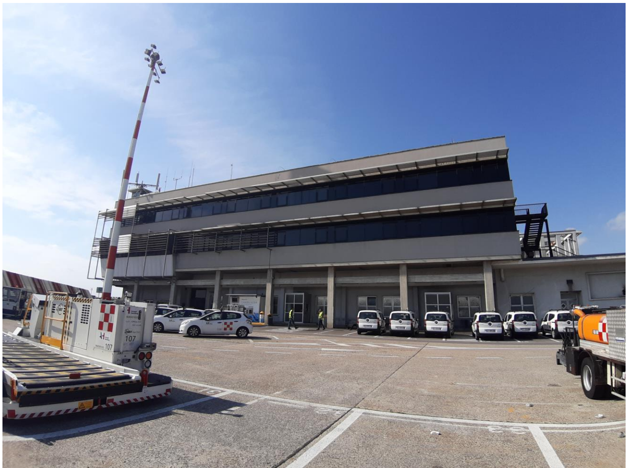
Fig.16 Oggi - Appendice Sud –fronte Sud
