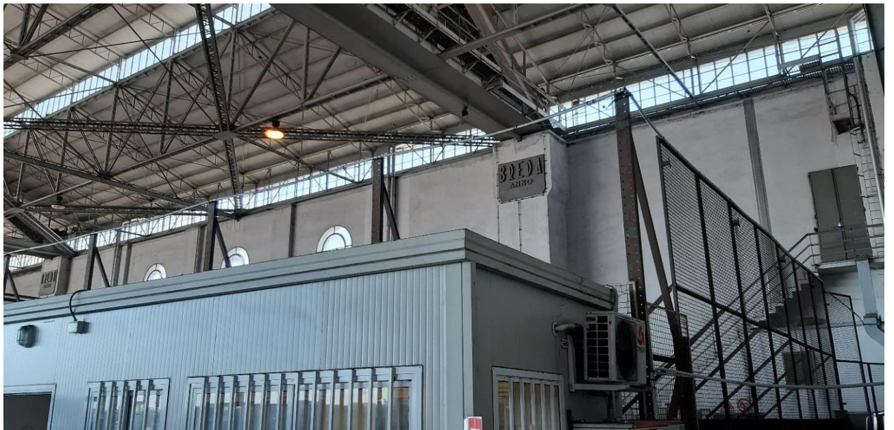
Fig.25 Oggi - Vista interna lato Nord – dettaglio
