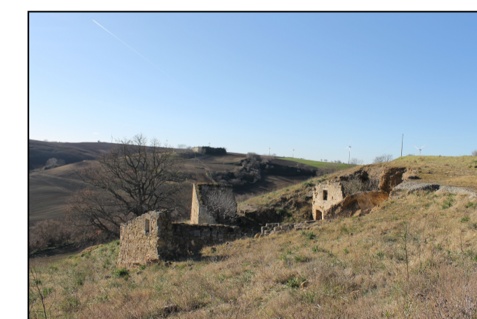
Foto - Vista fabbricato n. 78 rudere
