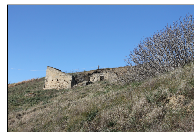
Foto - Vista fabbricato n. 81 rudere
