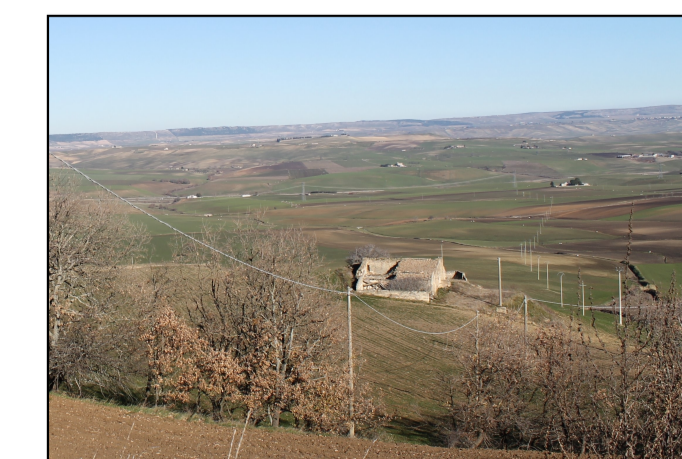
Foto - Vista da ovest fabbricato n. 80 rudere
