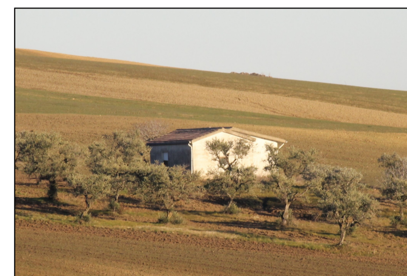
Foto - Vista fabbricato n. 55 - magazzino
