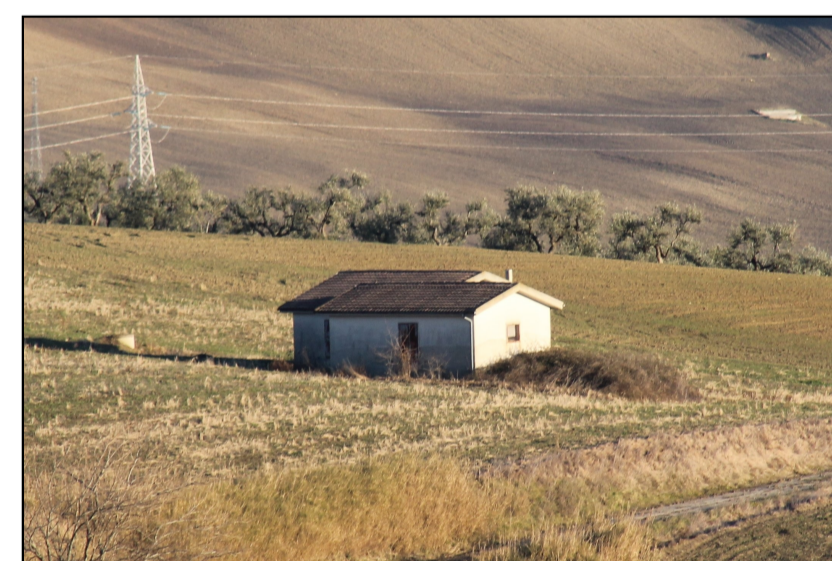
Foto - Vista fabbricato n. 41 - magazzino
