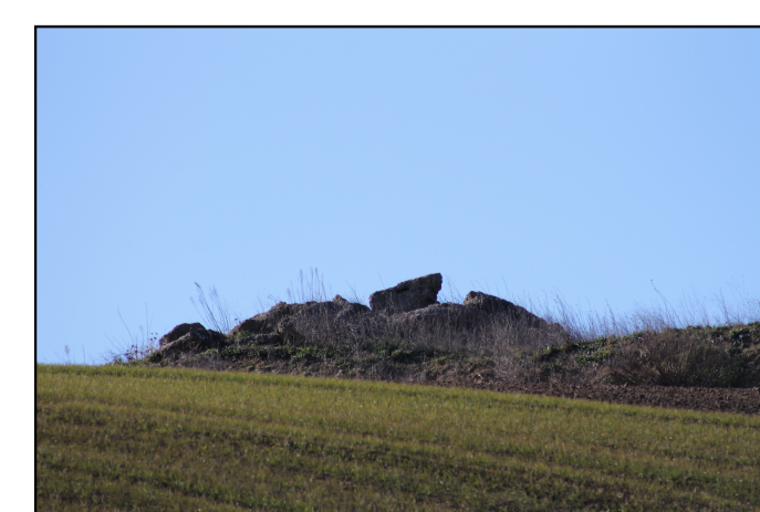
Foto - Vista fabbricato n. 79 - rudere
