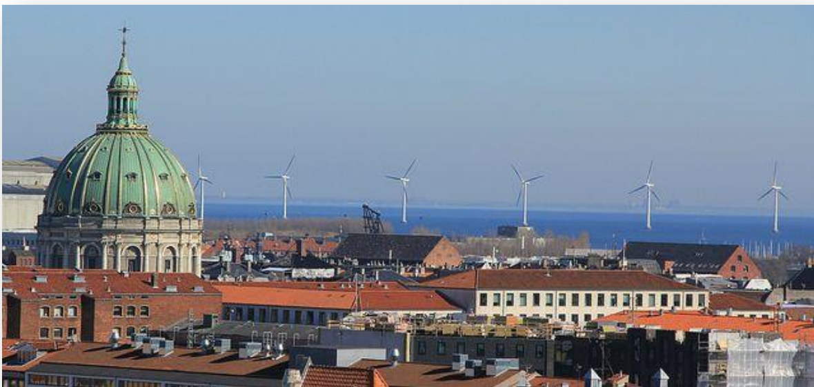
Figura 91 – Copenaghen vista panoramica
