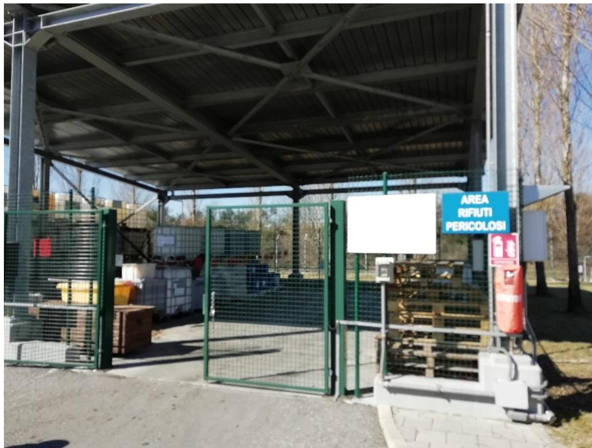
Figura 12 – Area di stoccaggio rifiuti pericolosi
