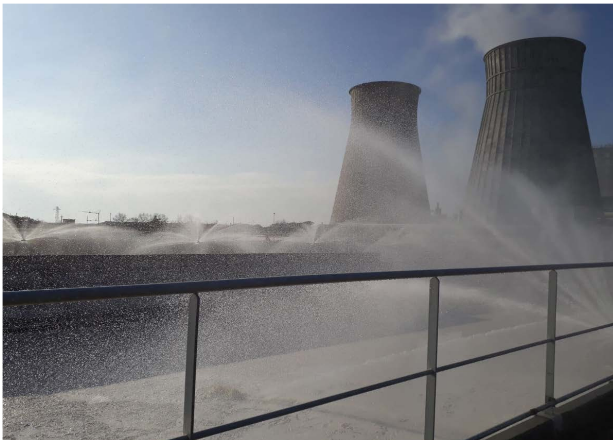
Figura 2.4: Sistema a muro d'acqua installato sul bacino di diversione in funzione (vista da est)
