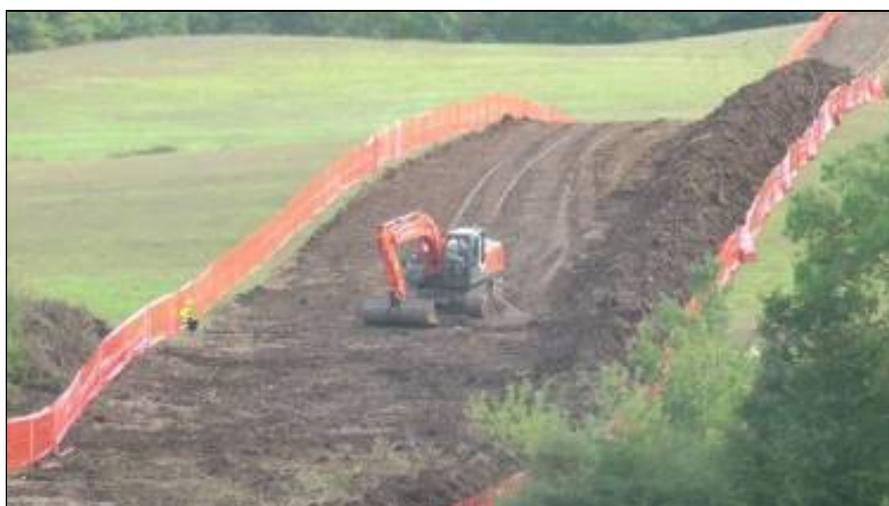
**Fig. 2.1 – Esempio di apertura pista di lavoro.**
