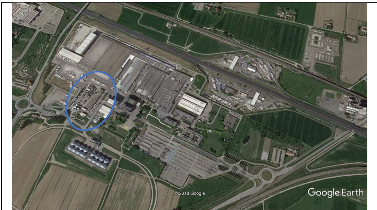
Fig. 5.1 – Veduta aerea dello stabilimento Barilla di Parma. Cerchiata in blu l'area dove verranno realizzate le principali opere oggetto dello studio
